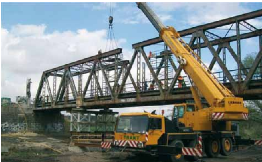
10 - 11. Demontaż mostu kratownicowego i jednocześnie przewiercanie korpusu przyczółka w miejscach projektowanych mikropali
