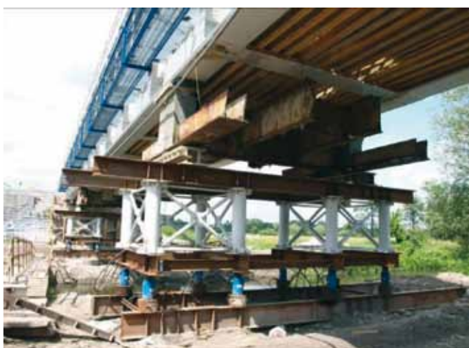
21. - 22. Podparcie tymczasowe na dźwignikach, szalunki elementów żelbetowych przęsła
