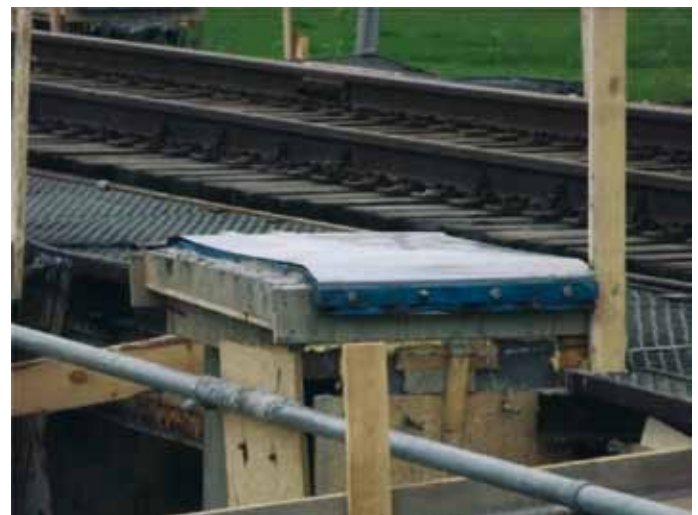
13. - 14. Szalunki do wykonania punktów stałych łożysk ślizgowych; widok łożyska
