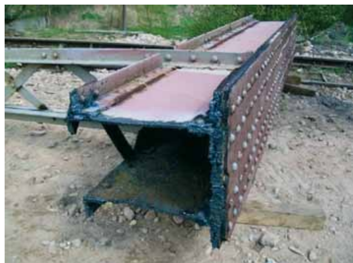
6. - 7. Widok węzła i przekrój poprzeczny pasa górnego
