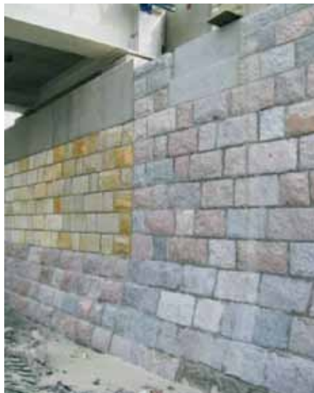
8 - 9. Piaskowanie kamiennych powierzchni przyczółków i jego efekty
