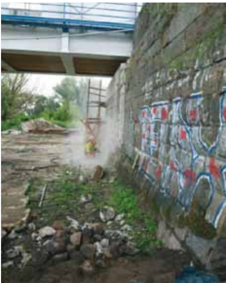
8 - 9. Piaskowanie kamiennych powierzchni przyczółków i jego efekty
