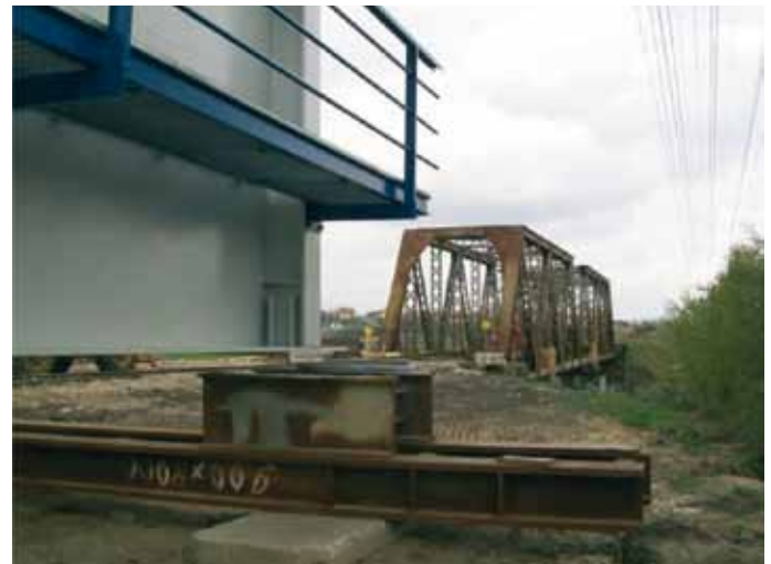
15. - 16. Przesunięcie poprzeczne ustroju nośnego na kierunek nasuwania podłużnego
