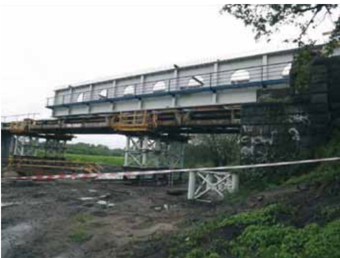
17. - 18. Nasuwanie podłużne przęsla stalowego przez napychanie
