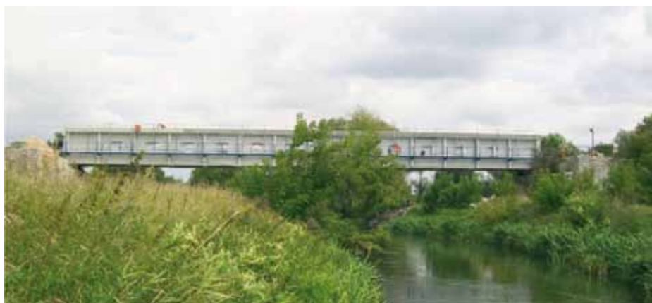
1. Widok na nowy most kolejowy, sierpień 2012
