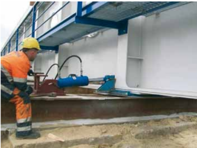
15. - 16. Przesunięcie poprzeczne ustroju nośnego na kierunek nasuwania podłużnego
