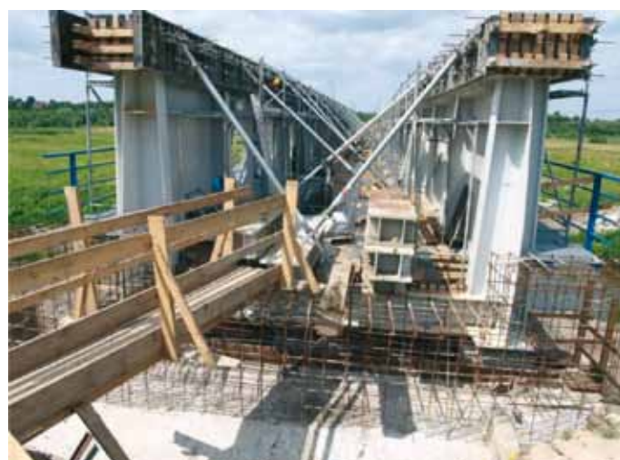
21. - 22. Podparcie tymczasowe na dźwignikach, szalunki elementów żelbetowych przęsła
