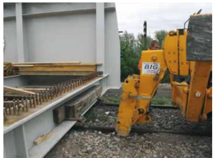
17. - 18. Nasuwanie podłużne przęsla stalowego przez napychanie
