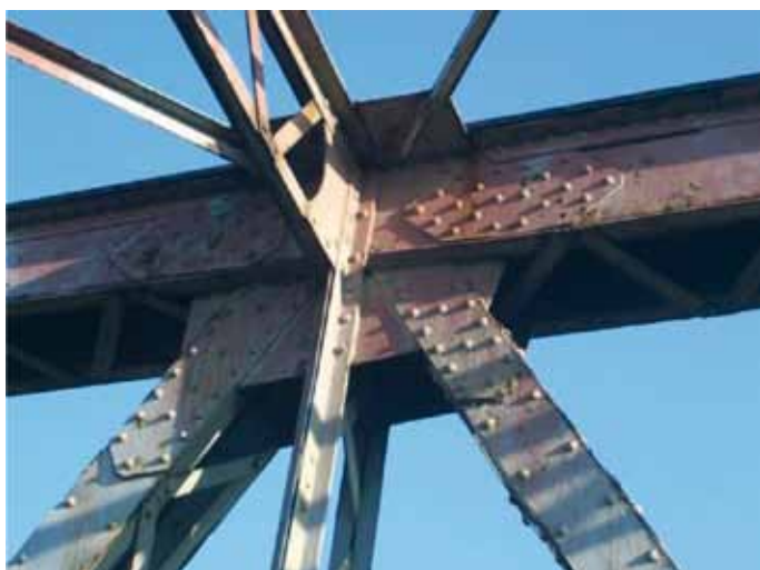
6. - 7. Widok węzła i przekrój poprzeczny pasa górnego
