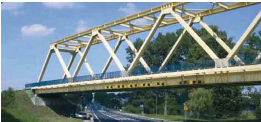
2. Wiadukt w Wilkołazie (belka wzmocniona kratownicą Warrena)
