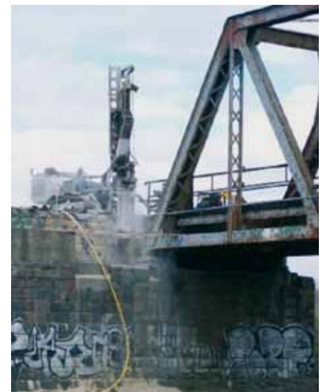
10 - 11. Demontaż mostu kratownicowego i jednocześnie przewiercanie korpusu przyczółka w miejscach projektowanych mikropali
