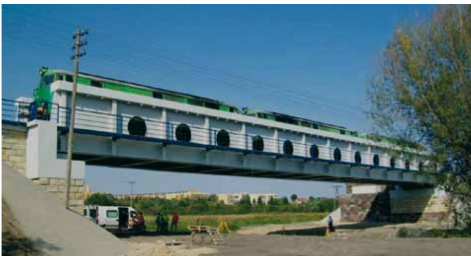
26. - 27. Próbne obciążenie
