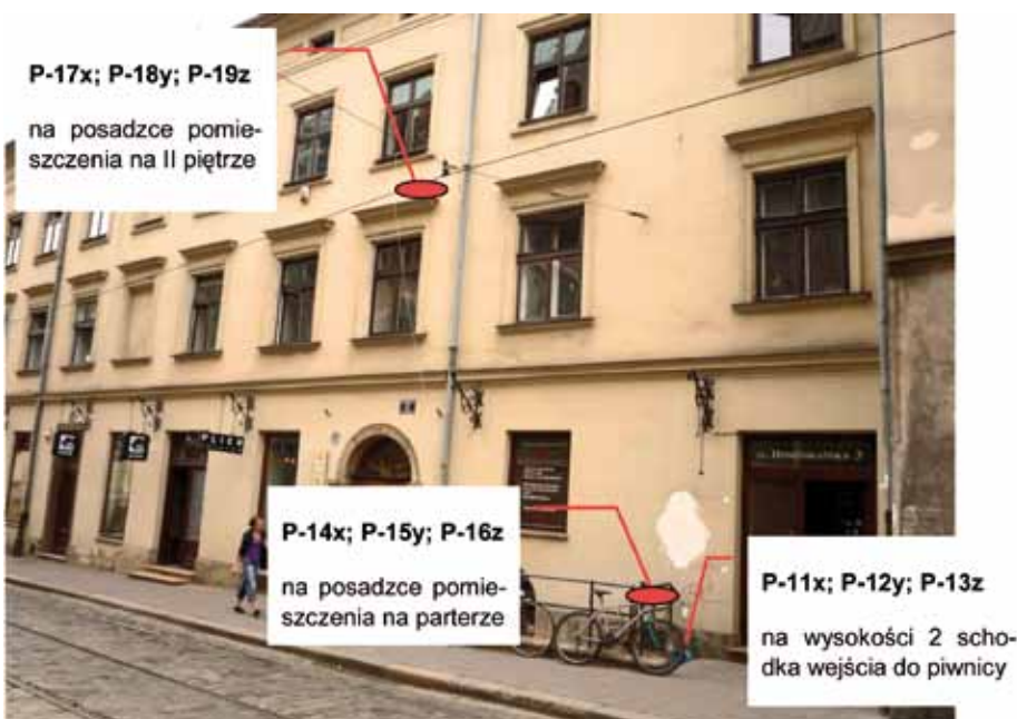
13. Schemat rozmieszczenia czujników w budynku D3
