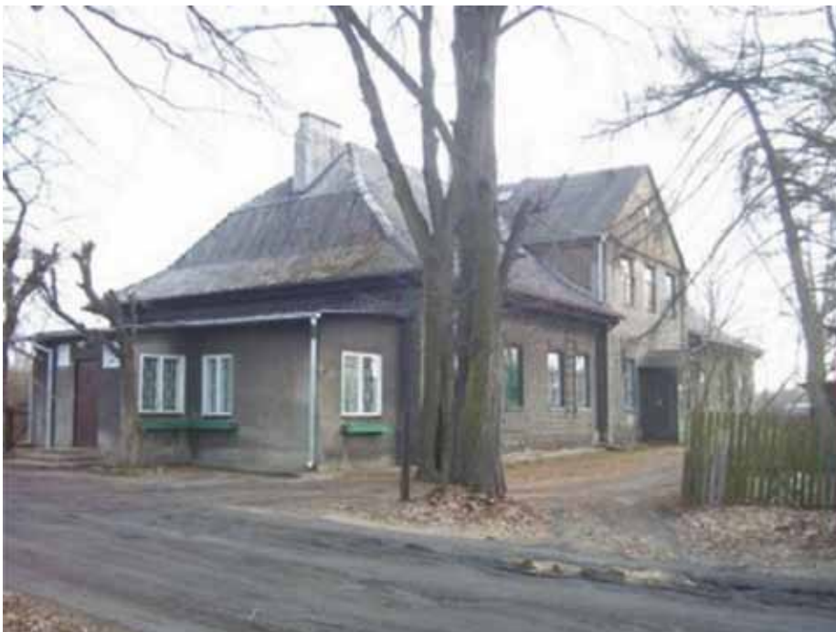
3. Budynek stacji Biała Podlaska Wąskotorowa, rok 2008 [1]
