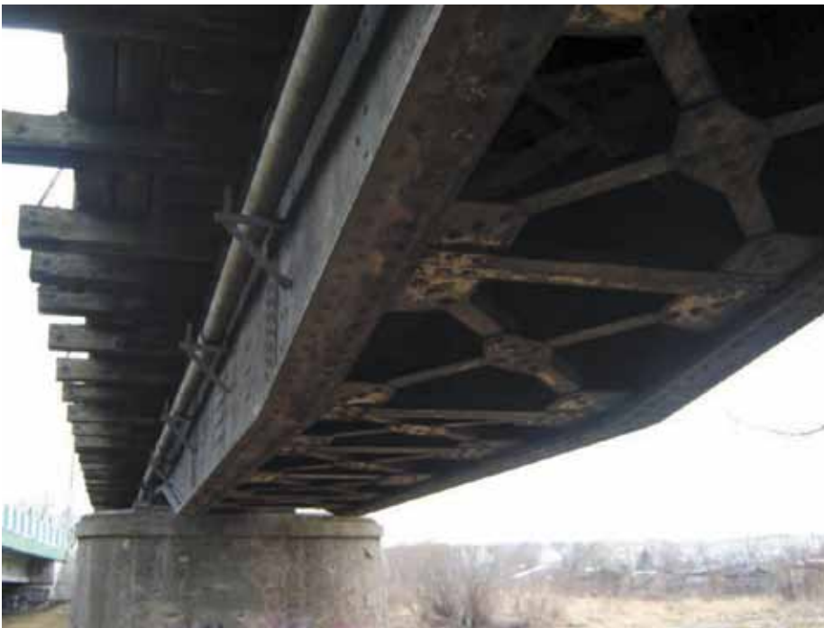
7. Widok spodu mostu [1]
