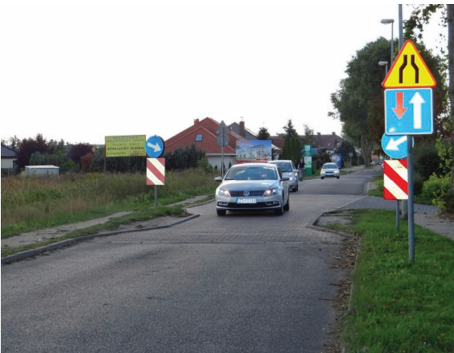
3. Przykład zwężenia jezdni do jednego pasa ruchu za pomocą dwóch naprzemianległych wydłużonych wysp bocznych (typu build-outs), zastosowanego na przedmieściach Szczecina (Fot. Alicja Sołowczuk)
