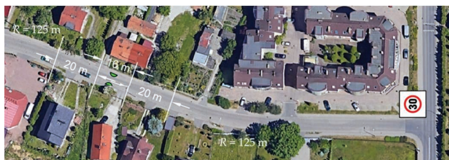
9. Rozmieszczenie przekrojów badawczych na ul. Zagony (Źródło: opracowanie własne)
