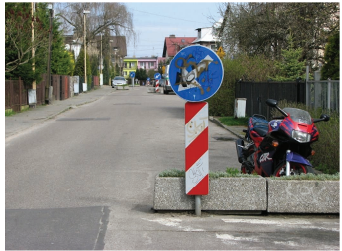
6. Seria szykan bocznych trójkątnych utworzonych z kwietników betonowych i ograniczone parkowanie w ich pobliżu (Fot. Alicja Sołowczuk)
