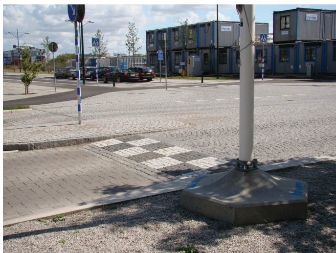
1. Przykład rampy najazdowej na wyniesione skrzyżowanie w Malmö (Fot: Stanisław Majer)
