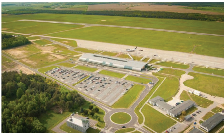
1. Widok lotniska z infrastrukturą. Foto Autora
