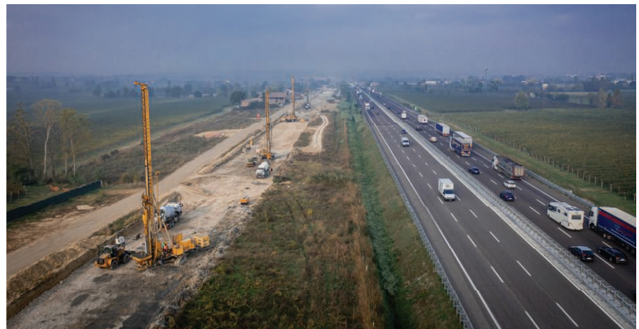
12. Realizacja kolumn wibrowymiany [4]
