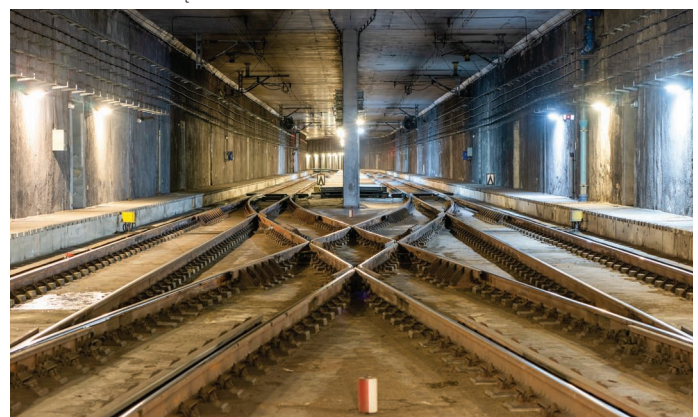
3. Warszawa tunel prowadzący na Lotnisko Chopina, 2024, materiały własne
