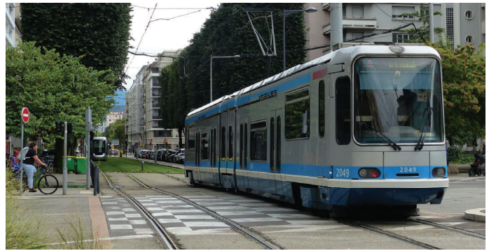
12. Specjalny sposób oznakowania przejazdu dla samochodów przez torowisko tramwajowe stosowany we Francji i Belgii - tu przykład z Grenoble (fot.: Igor Gisterek)
