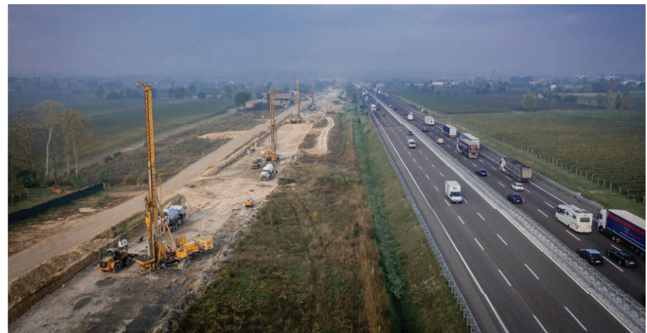
12. Realizacja kolumn wibrowymianowych [4]
