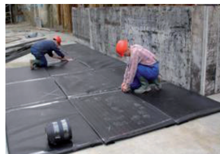
5. Lenbach Gärten w Monachium, posadowienie na warstwie elastycznej Calenberg Cimax – układanie warstwy w wykopie
