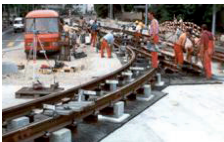
16. Light Mass-Spring-System na macie USM 1000W w miejscu rozjazdu
