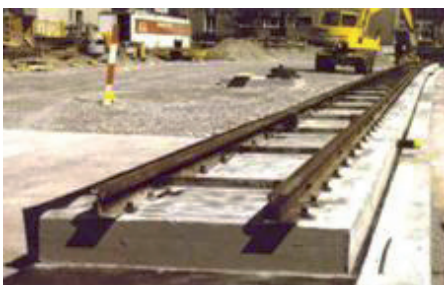
15. Light Mass-Spring-System po szalunku
