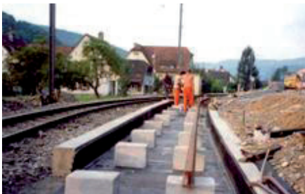
14. Light Mass-Spring-System na macie pod podłożem toru USM 1000W przed betonowaniem
