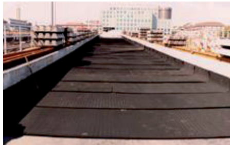
13. Tor podsypkowy na moście przed wykonaniem nawierzchni
