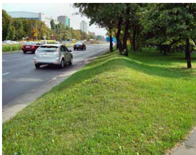
18. Nasyp z pokrywa trawiastą jako skuteczna ochrona hałasu opon
