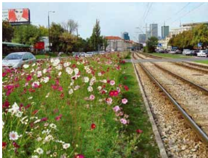
14. Ochrona barierą roślinności torowiska tramwajowego
