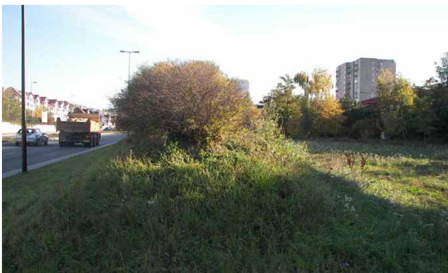
2. Przykład ziemnego ekranu akustycznego z krzewami
