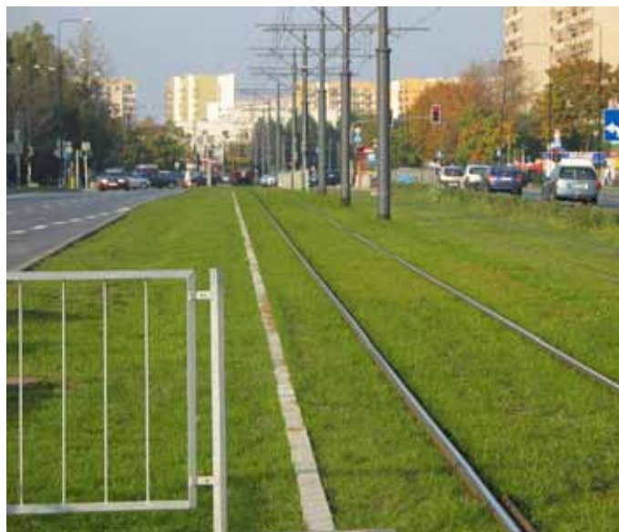
16. Trawnik częściowego wytłumienia torowiska tramwajowego
