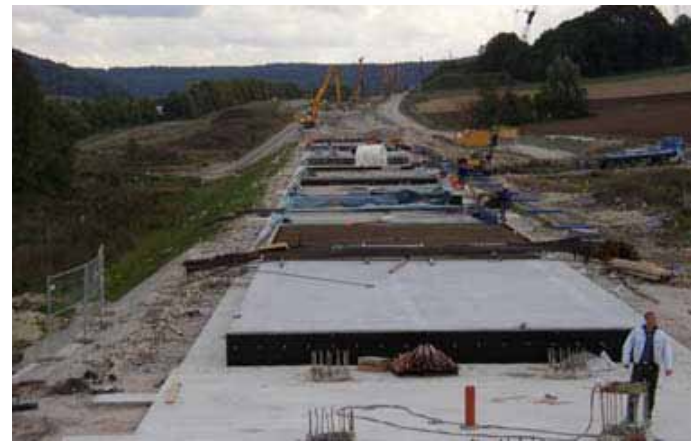
14. Wykonywanie systemu z wykorzystaniem płyt i pali dla nawierzchni szynowej bezpodsypkowej
