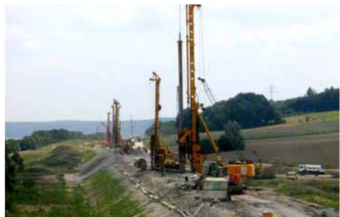
12. Wbijanie pali na linii kolejowej relacji Norymbergia – Ingolstadt dla nawierzchni szynowej bezpodsytkowej
