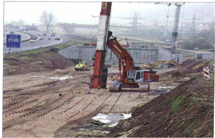
10. Wykonywanie pionowego drenażu w gruncie miękkim - posadowienie nasypu kolejowego
