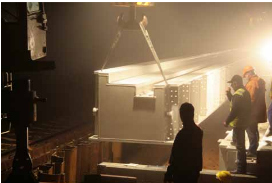
3. Zabudowa konstrukcji tymczasowych dł. 30m w km 157,868 w porze nocnej przy 5-cio godzinnym wstrzymaniu ruchu na linii
