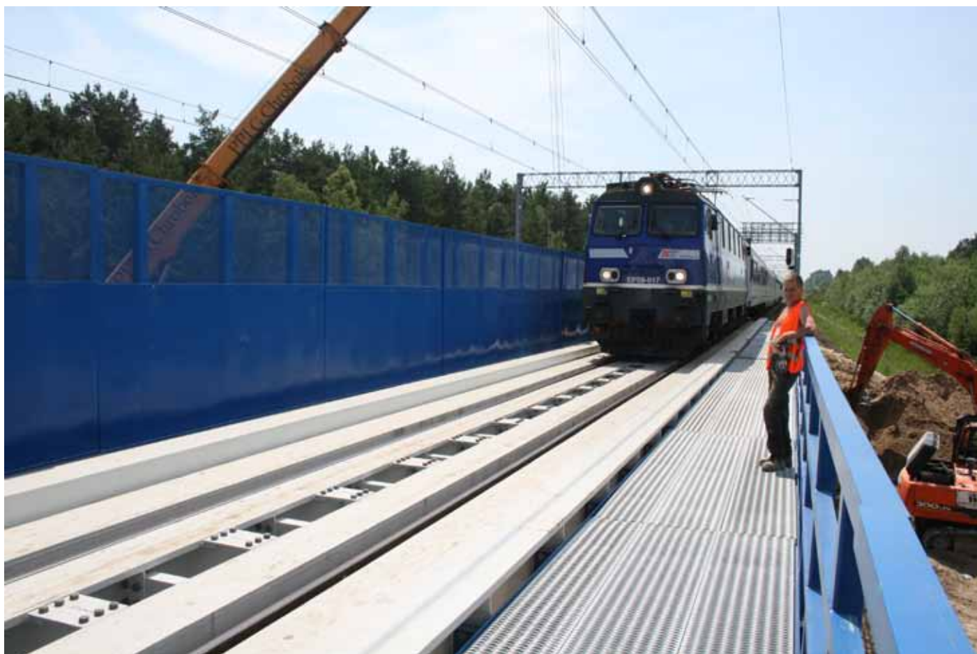
1. Dwie konstrukcje tymczasowe dł. 25mb w km 159,992 tor nr 1 z widocznymi ekranami zabezpieczającymi i chodnikiem
