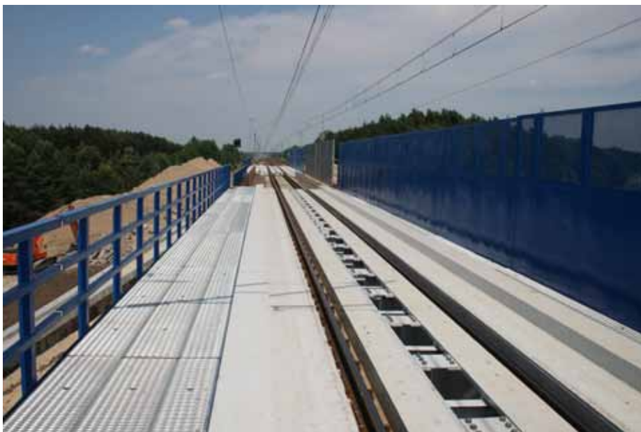
2. Konstrukcje tymczasowe dł. 30 m km 157,868 tor nr 1
