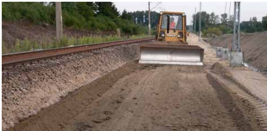
11. Profilowanie wykonanej warstwy podłoża
