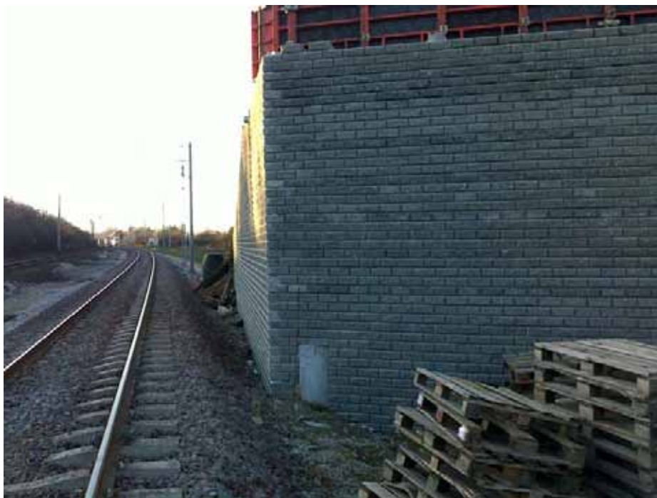
12. Ściana z gruntu zbrojonego w końcowej fazie realizacji
