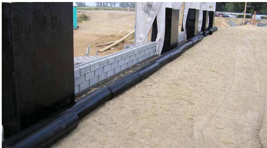
17. Pasma georusztów przygotowane do rozwinięcia
