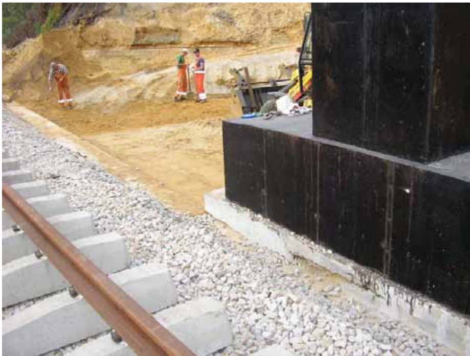
9. Przygotowywanie podłoża pod wykonanie konstrukcji z gruntu zbrojonego
