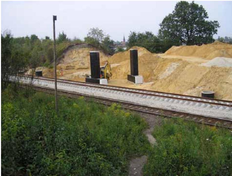
8. Słupy konstrukcji żelbetowej
