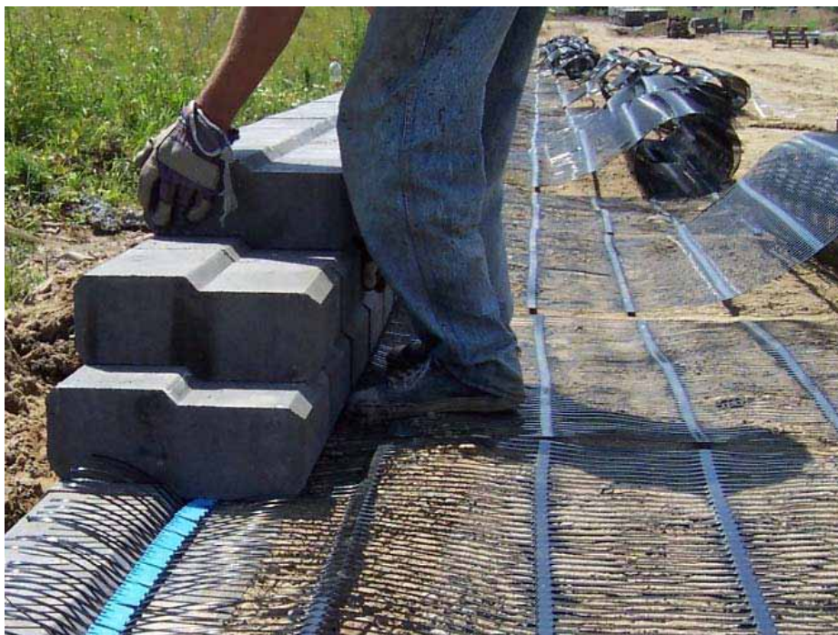
11. Układanie bloczków Dermat oraz georusztów
