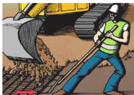
11. Naprężanie pasma georusztu
