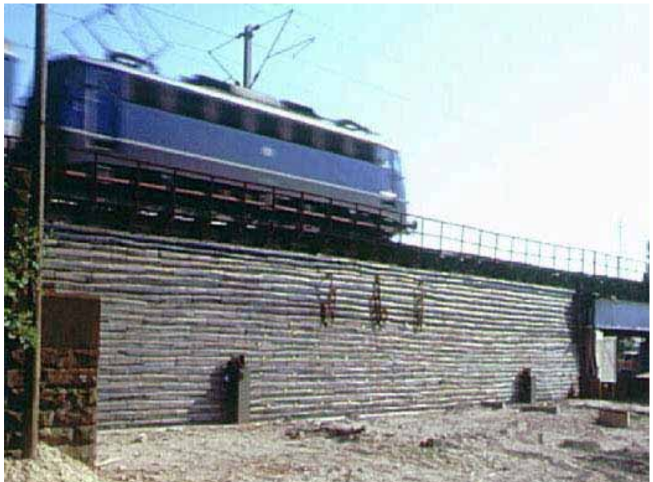
1. Ściana oporowa wykonana w systemie wrap-around
