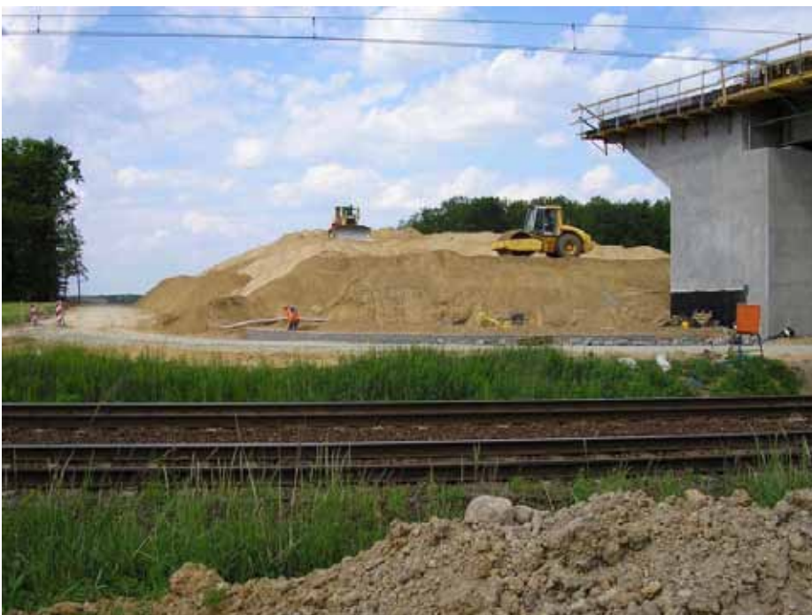
15. Początek wznoszenia konstrukcji z gruntu zbrojonego
