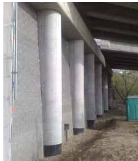
18. Lico muru TW1 w końcowej fazie wykonywania konstrukcji
