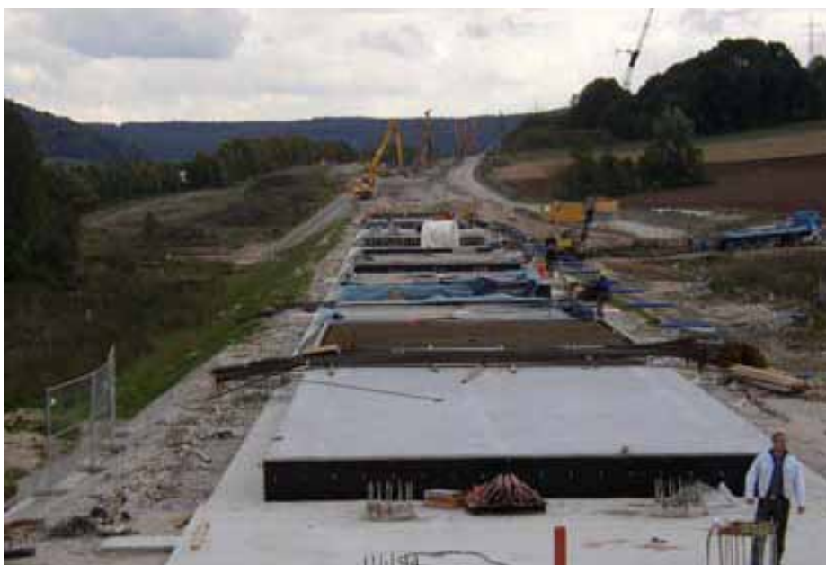
7. Wykonywanie systemu z wykorzystaniem płyt i pali dla nawierzchni szynowej bezpodсыpkowej
