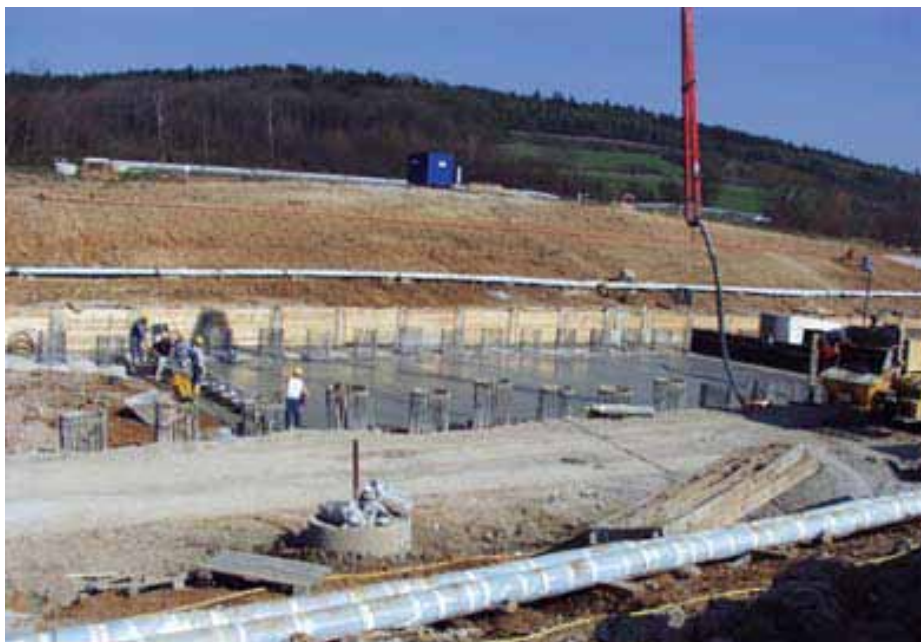
8. Początek prac nad korytem w kierunku południowym
