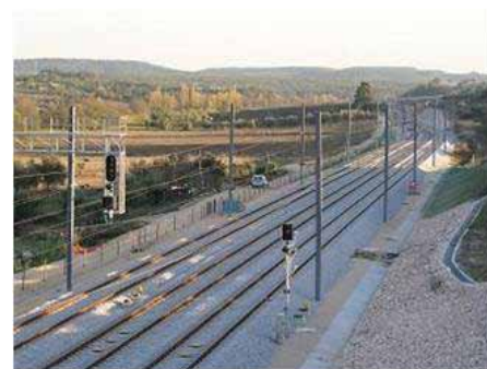
6. Widok linii kolejowej po modernizacji
