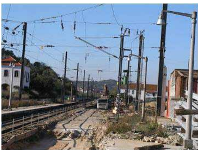
1. Konieczność utrzymania ruchu pociągów oraz niewielka przestrzeń dla wykonywania prac modernizacyjnych stanowiła nie lada wyzwanie dla wykonawców
