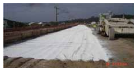
4. Do rozsiewania wapna wykorzystano rozsiewacze stosowane powszechnie w drogownictwie
