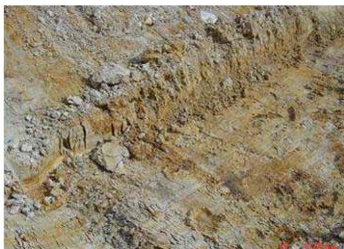
3. Grunt w istniejącym podtorzu, to przede wszystkim glina, usunięto 20 cm warstwę nasypu, dalsze 35 cm zastabilizowano wapnem palonym
