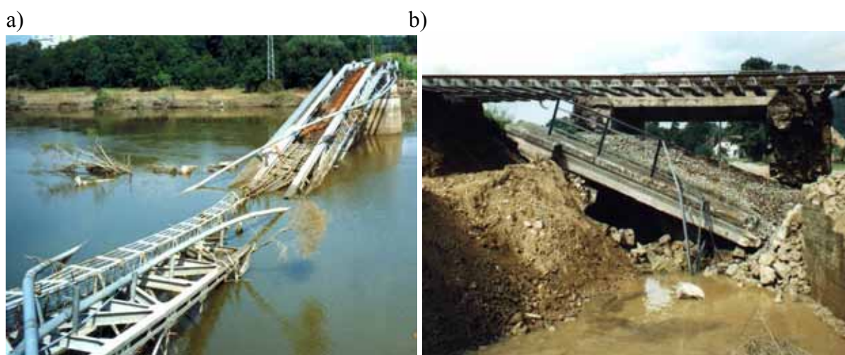
8. Katastrofy mostów kolejowych w wyniku powodzi: a) na skutek podmycia i wywrócenia podpory pośredniej, b) z powodu rozmycia nasypu oraz uszkodzenia przyczółków
