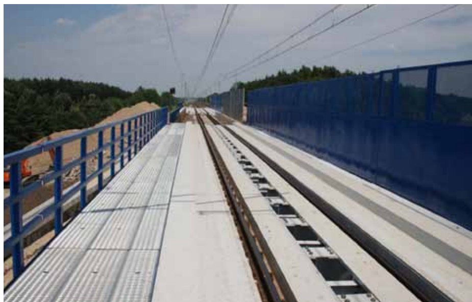
2. Konstrukcja tymczasowa – widok z góry
