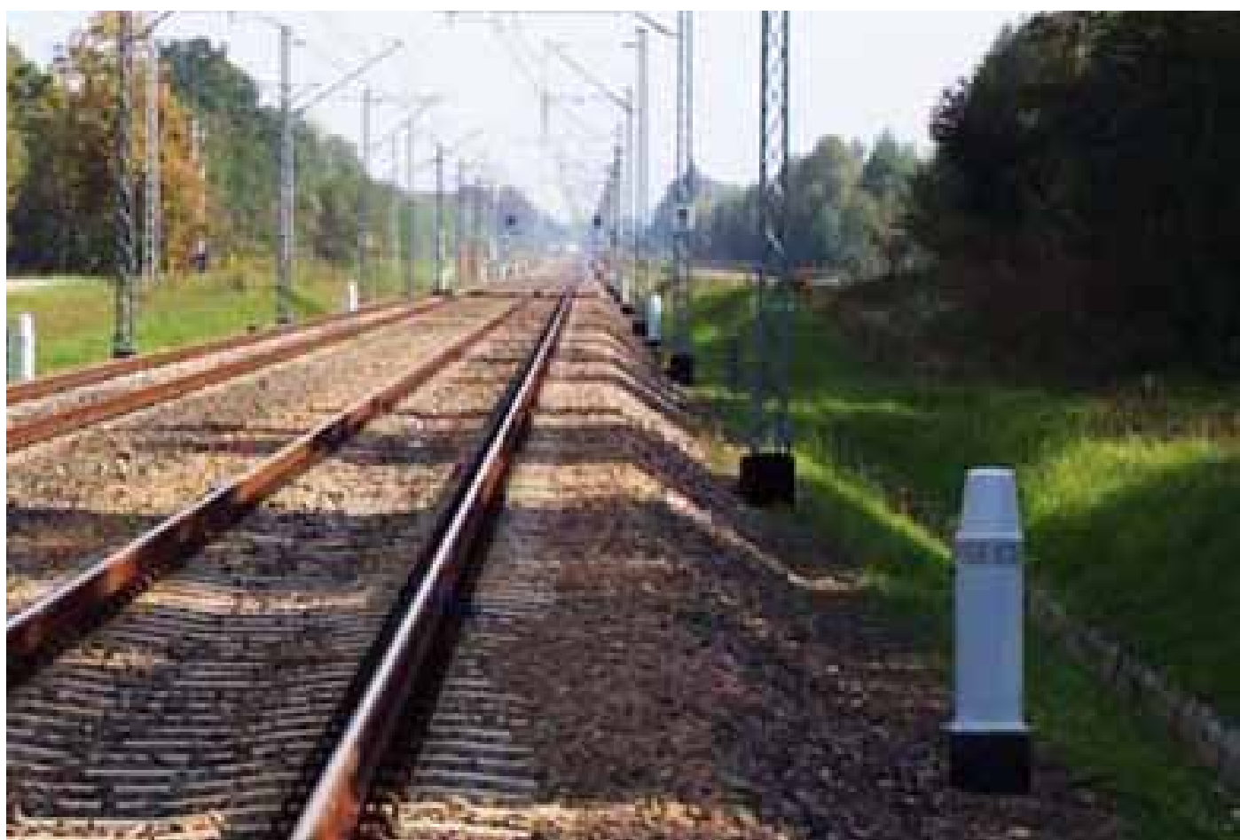
1. Widok fragmentu magistrali E-20 Mińsk Mazowiecki-Siedlce z zainstalowanymi prewenterami UOZ-1 [3], fot. Bombardier
