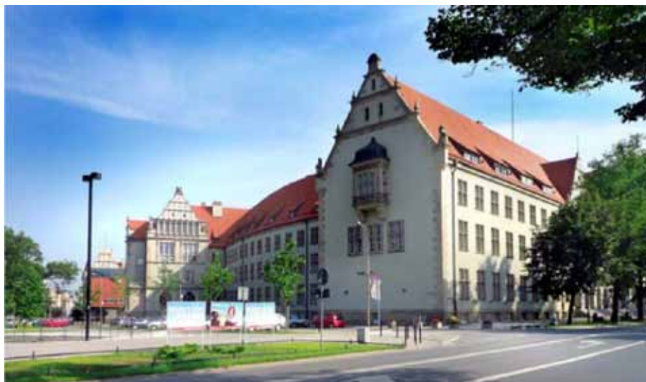
2. Aktualny widok Gmachu Głównego
