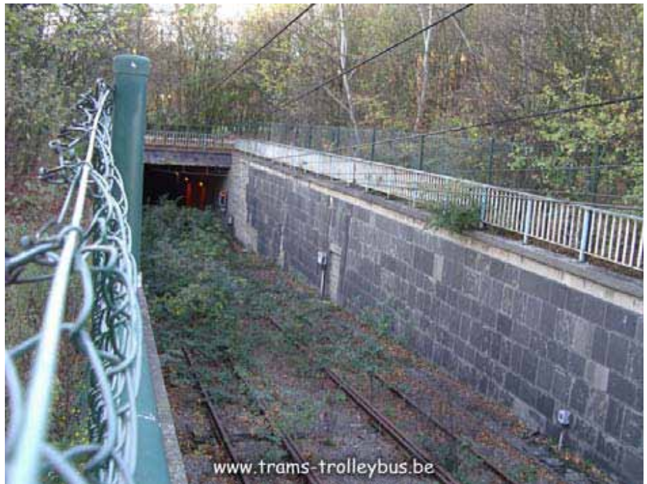
4. Niedokończona budowa szybkiego tramwaju w Charleroi (Belgia) [3]
