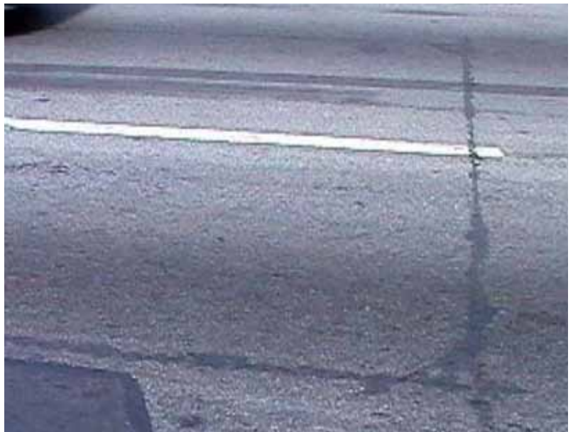
1. Pętle indukcyjne ułożone w nacięciu warstwy ścierniczej w nawierzchni jezdni
