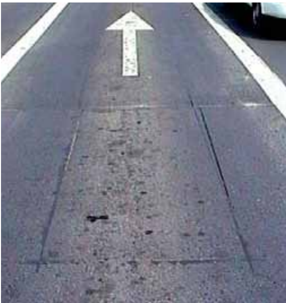
1. Pętle indukcyjne ułożone w nacięciu warstwy ścierniczej w nawierzchni jezdni
