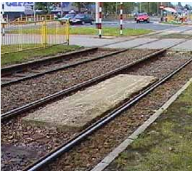
2. Pętle indukcyjne w torowisku (w płycie betonowej w torowisku otwartym i zabudowanym)
