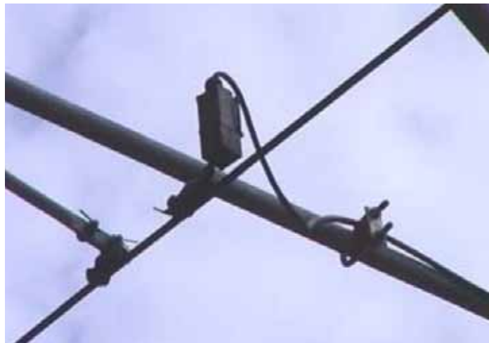
3. Radar umieszczony na konstrukcji wsporczej dla sygnalizacji oraz czujnik indukcyjny na trakcji tramwajowej
