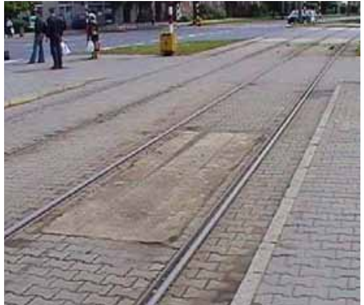
2. Pętle indukcyjne w torowisku (w płycie betonowej w torowisku otwartym i zabudowanym)
