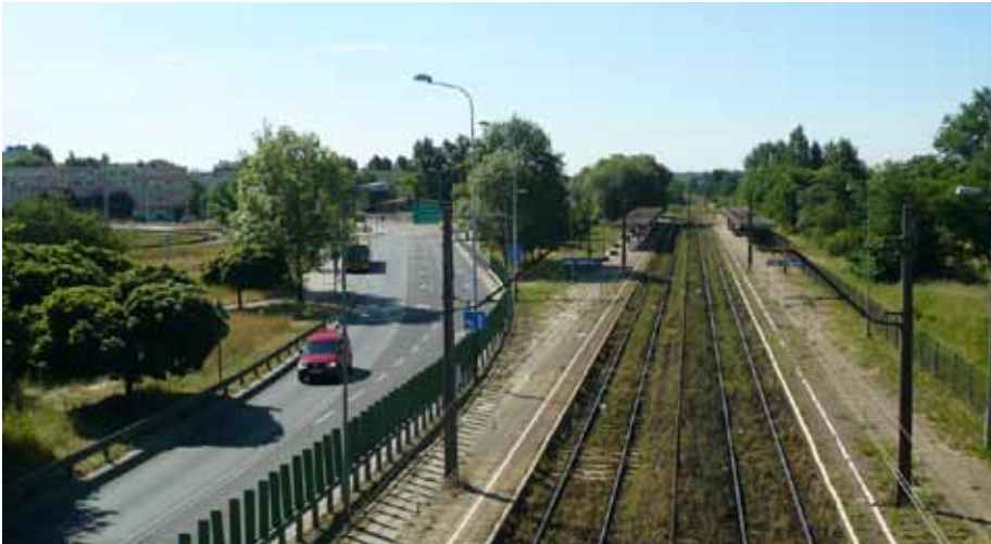
2. Przykład błędów popełnionych podczas modernizacji węzłów komunikacyjnych na stacji Łódź Żabieniec: płot uniemożliwiający swobodne dojście na przystanek autobusowy i do pętli tramwajowej; zlikwidowano też zejście na perony z wiaduktu, z którego wykonano zdjęcie
