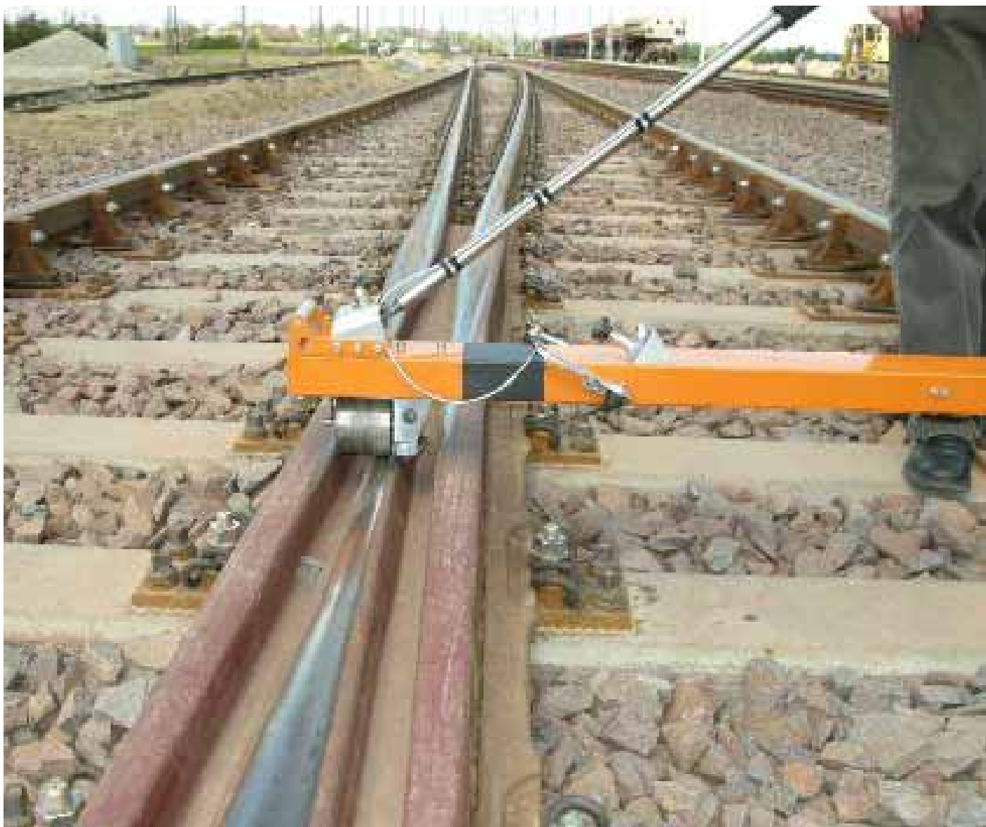
6. Przejazd przez dziób krzyżownicy
