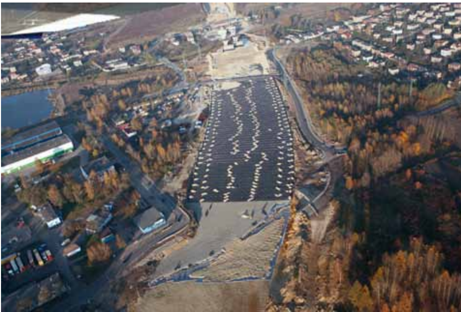
12. Zdjęcie lotnicze budowy autostrady A1
