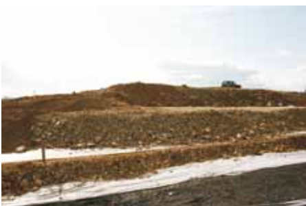
14. Budowa nasypu zbrojonego geosyntetykami
