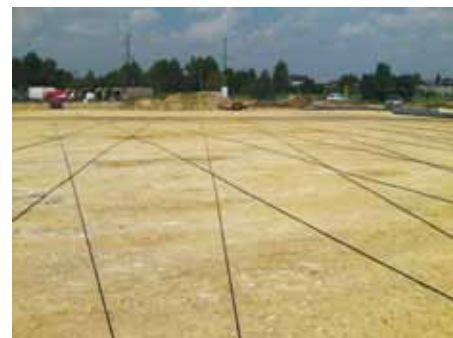
10. Instalacja systemu monitoringu w warstwie dolnej
