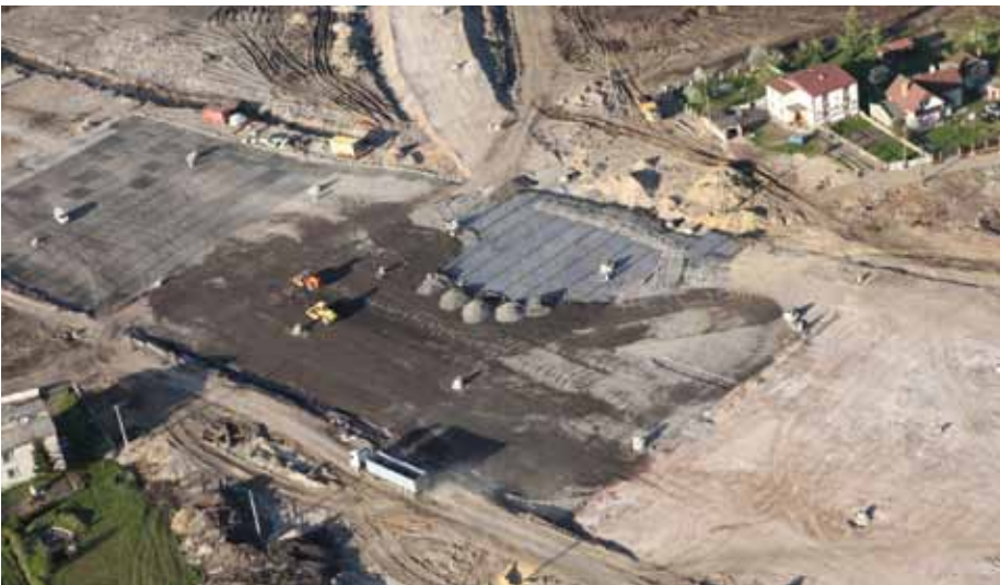
13. Zdjęcie lotnicze budowy autostrady A1
