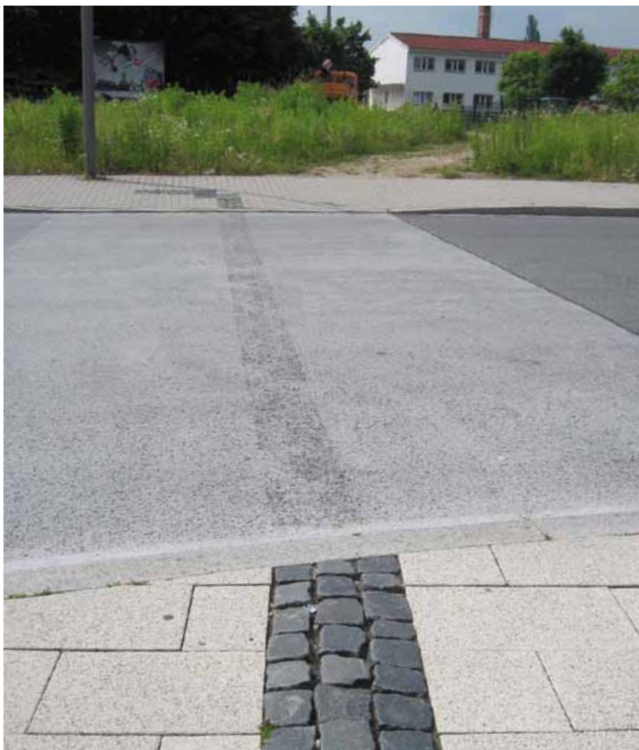
6. Pas prowadzący w formie sfrezowanej nawierzchni jezdni
