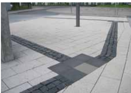
2. Oznaczenie pola wyboru drogi za pomocą nawierzchni o innej fakturze
