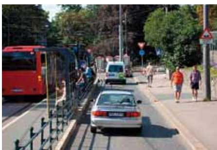
a. wydzielone torowisko autobusowo-tramwajowe
