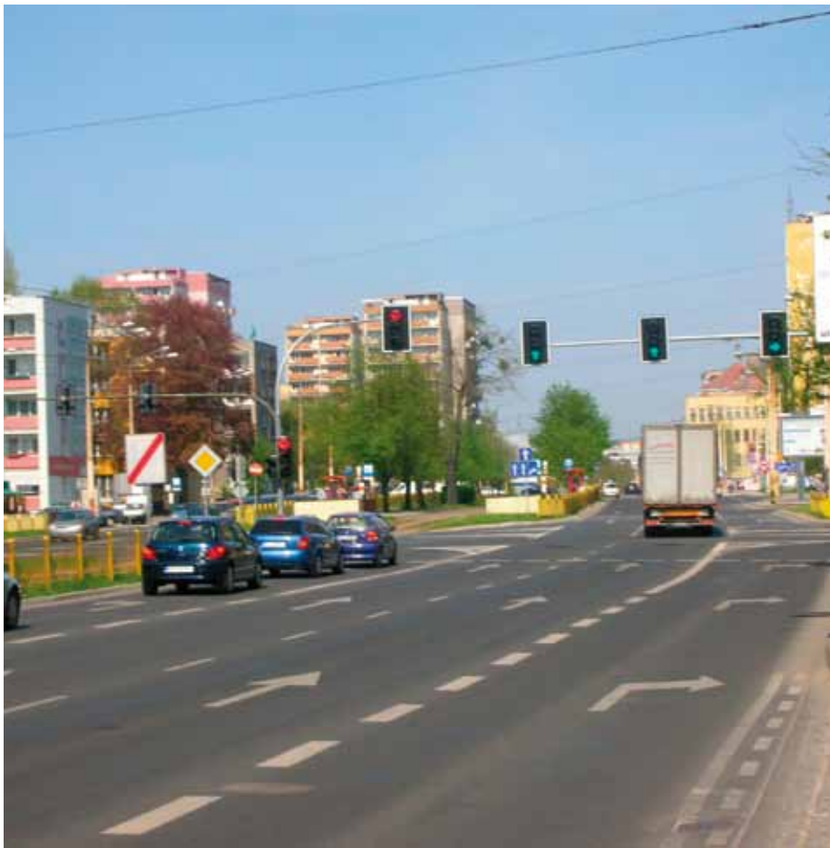
5. Skrzyżowanie Wyzwolenia-Malczewskiego po modernizacji
