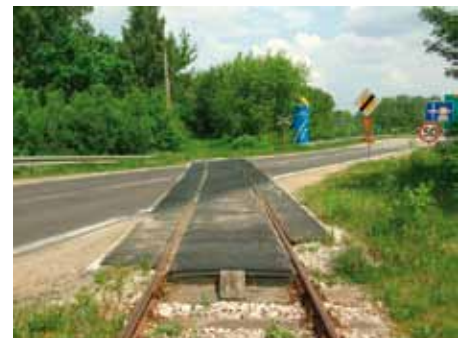
8. Przejazd kolejowy w km 2,881
