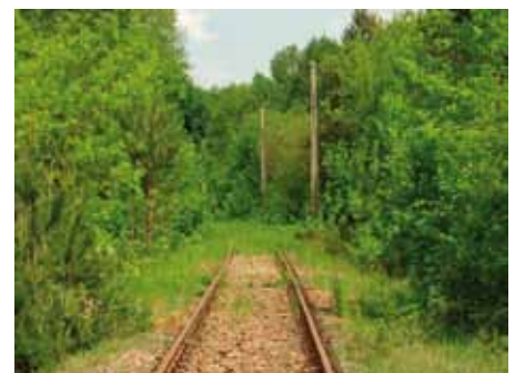
9. Rozebrana sieć trakcyjna
