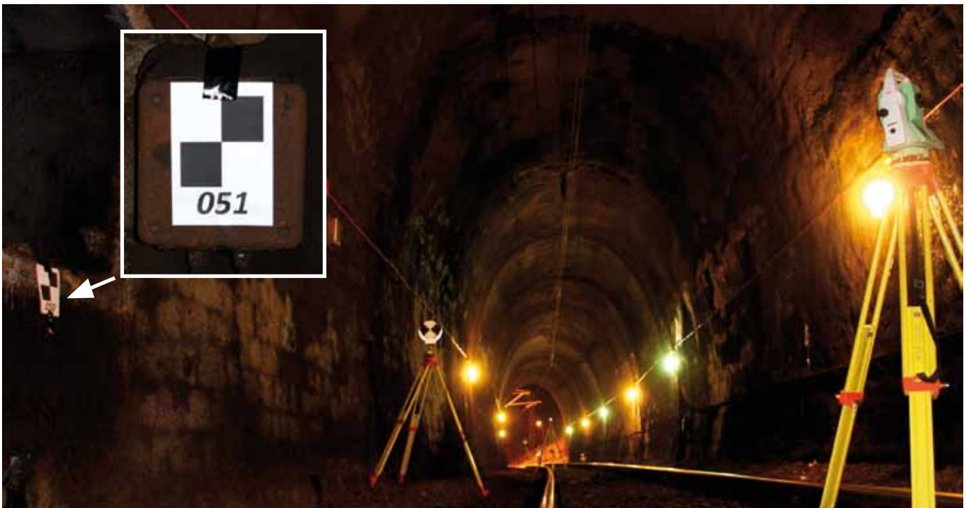
5. Baza pomiarowa zlokalizowana w tunelu kolejowym August
