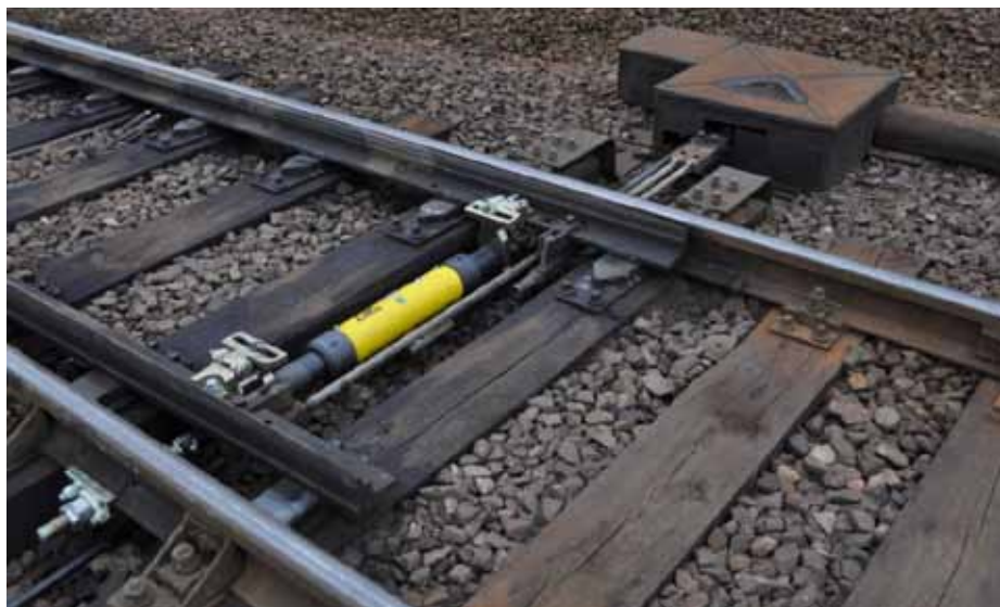
6. Przykłady zabudowy zamknięć SPHEROLOCK NG: Rz S49-190, 1:9, podrojazdnice drewniane, napęd mechaniczny
