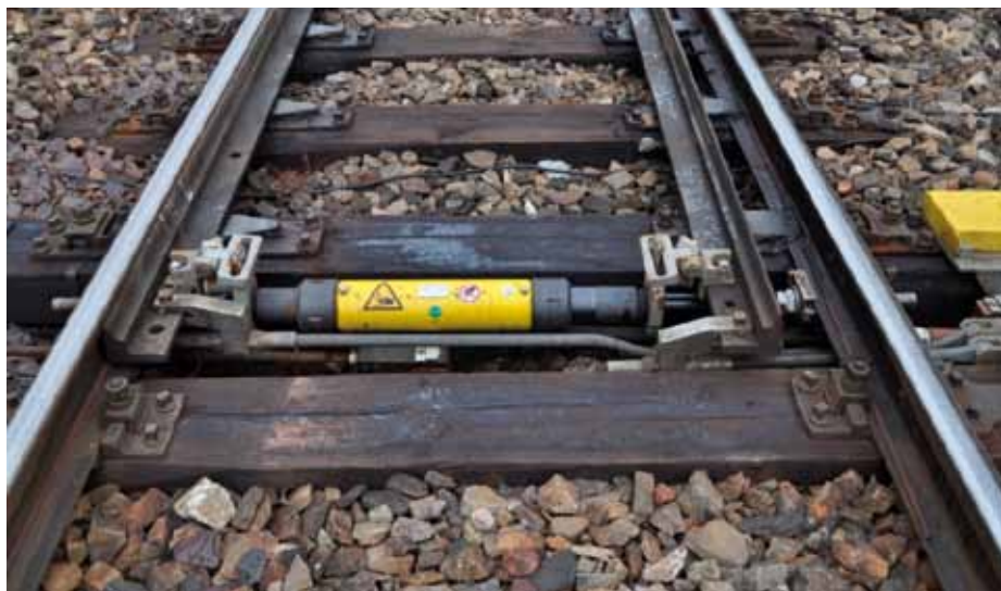
5. Przykład zabudowy zamknięcia SPHEROLOCK NG: Rz S49-300, 1:9, podrojazdnice drewniane, napęd EEA5
