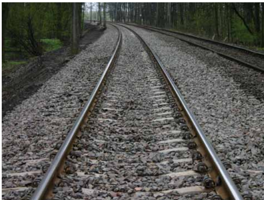
1. Nawierzchnia kolejowa na badanym odcinku toru
