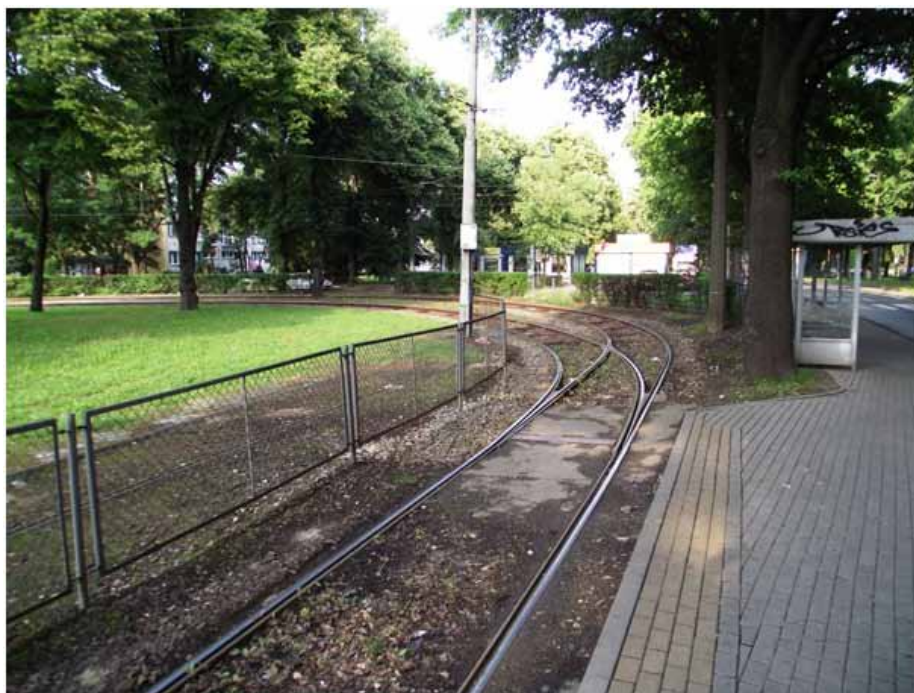
1. Fragment istniejącej pętli tramwajowej z widokiem na rozgałęzienie rozjazdem toru wewnętrznego od toru głównego
