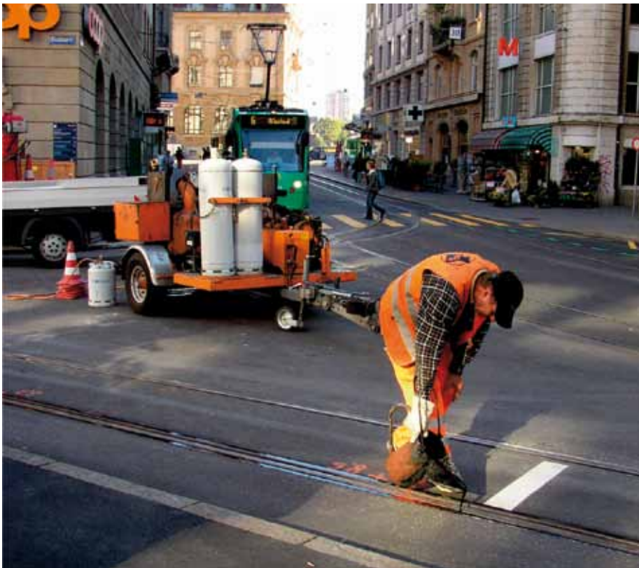
3. Konserwacja polegająca na wymianie bitumicznego uszczelnienia przyszynowego.
