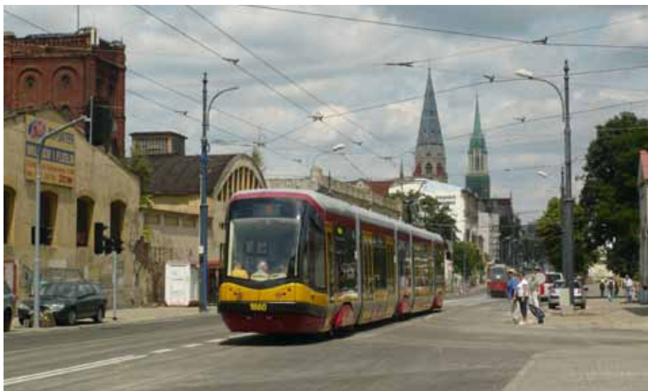
3. Etap I projektu Łódzkiego Tramwaju Regionalnego objął instalację obszarowego systemu sterowania dającego warunkowy priorytet tramwajom
