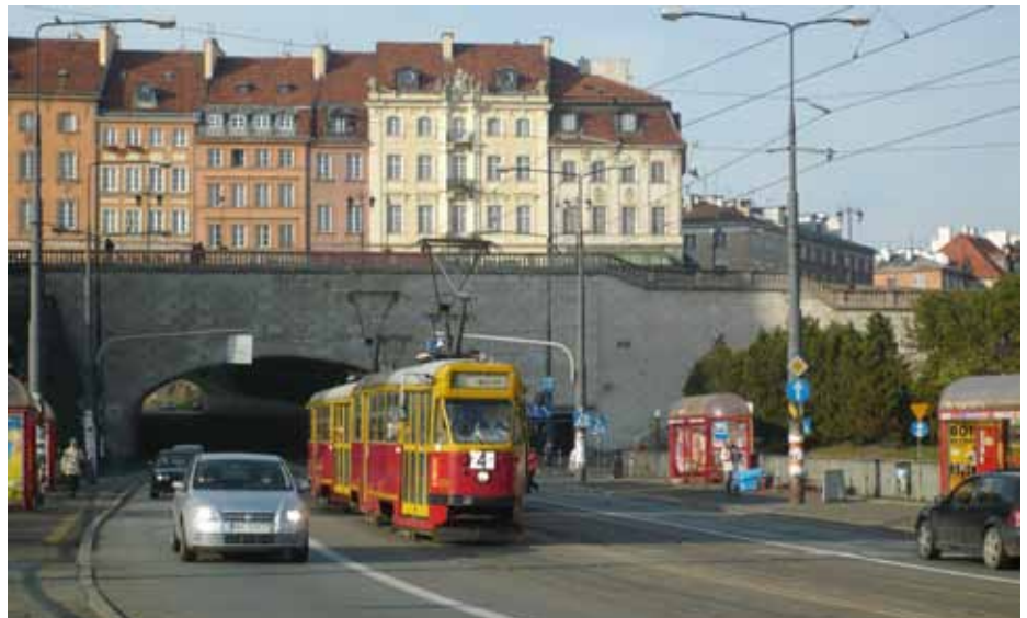
1. Przykład wydzielonego pasa dla autobusów i tramwajów w Al. Solidarności (trasa W Z) w Warszawie
