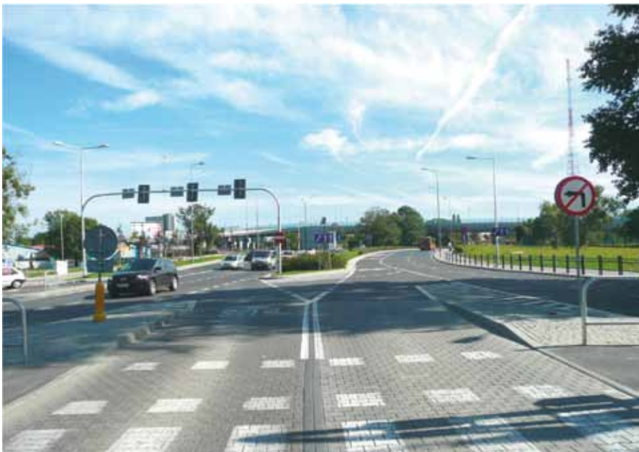
8. Widok na skrzyżowanie ul. Strzegomskiej z ul. Nowodworską w kierunku centrum. Widać zwężenie pasa pod torowiska tramwajowe za skrzyżowaniem.
