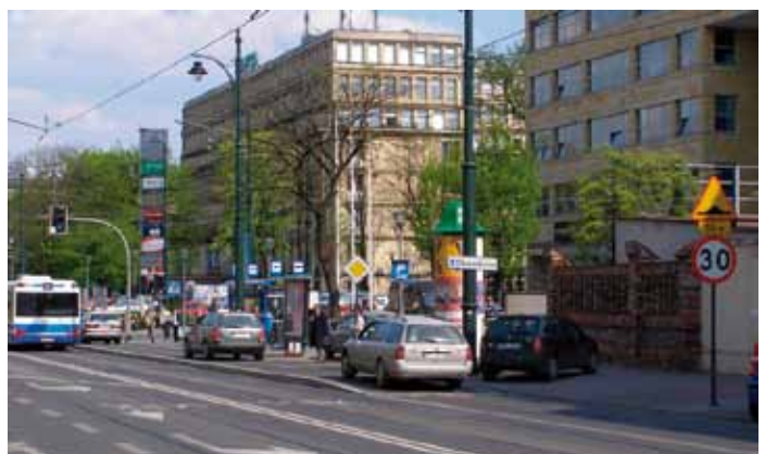
6. Podwyższenie jezdni na długości przystanku tramwajowego
