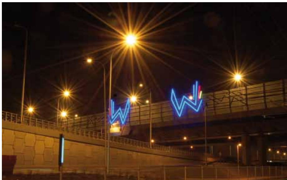
13. „Brama wjazdowa” do miasta na ekranie wiaduktu WA 19 nad ulicą Kosmonautów w ciągu DK 94 (węzeł Wrocław Stadion)
