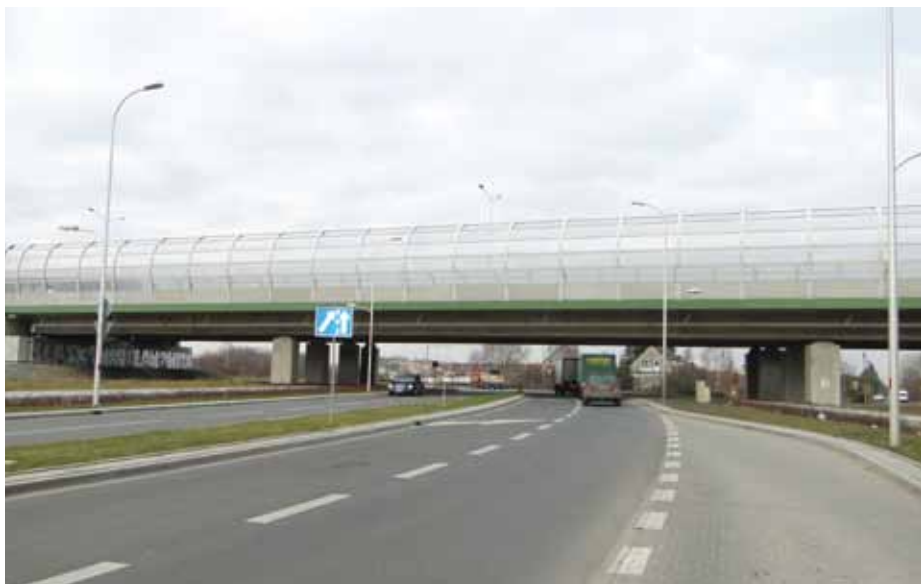
9. Estakada WA 20 nad ulicami Królewiecką i Maślicką
