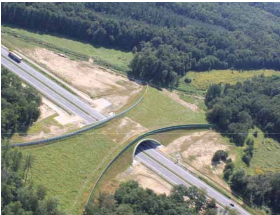
11. Przejście dla zwierząt KZ-B nad Łącznikiem Długołęka
