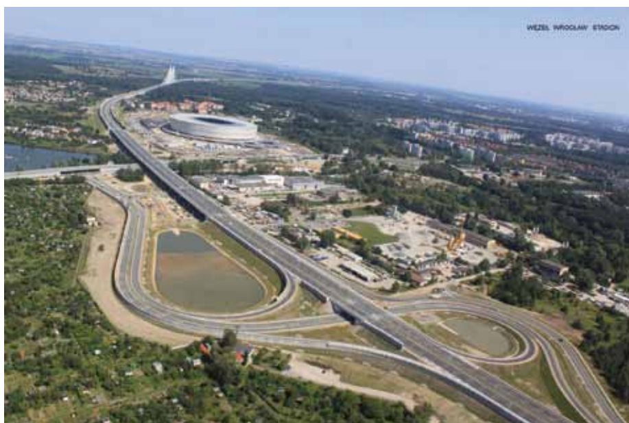
4. Węzeł „Wrocław Stadion” autostrady A8 z ulicą Kosmonautów we Wrocławiu (DK 94). Z lewej strony widoczny dodatkowy wiadukt nad skrzyżowaniem ulicy z łącznicą węzła zrealizowany wspólnie przez miasto Wrocław i GDDKiA
