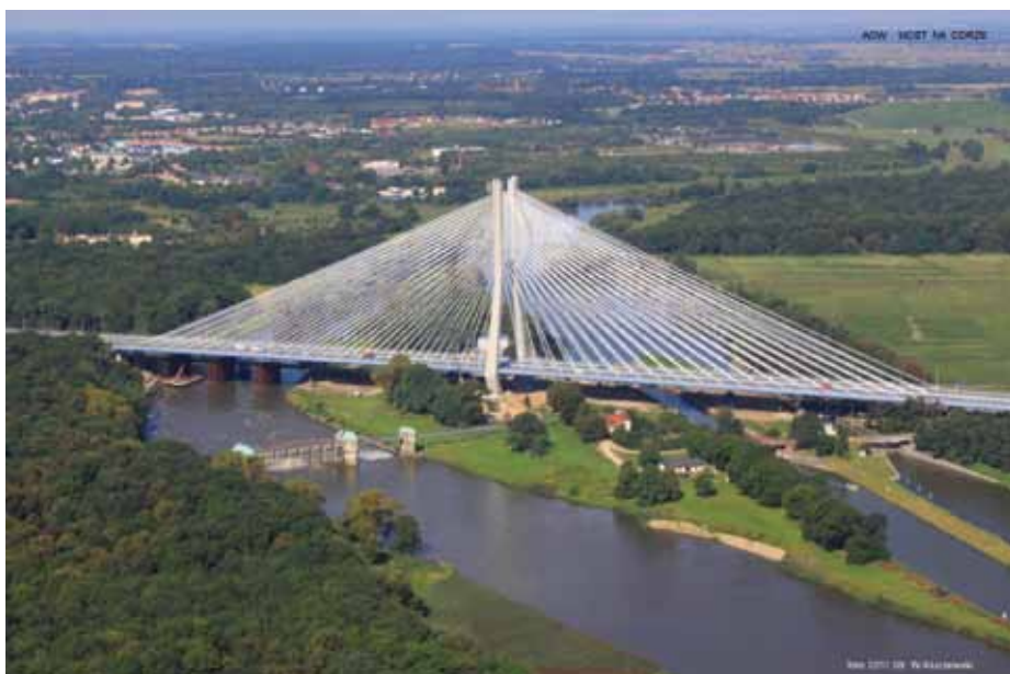
10. Most MA 21' przez rzekę Odrę. Przęsła podwieszono
