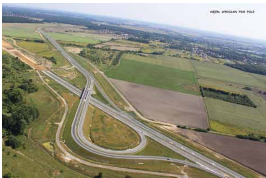
7. Węzeł „Wrocław Psie Pole” autostrady A8 z drogą ekspresową S8 (docelowo) i „Łącznikiem Długoleka.” Widoczna droga S8 w budowie
