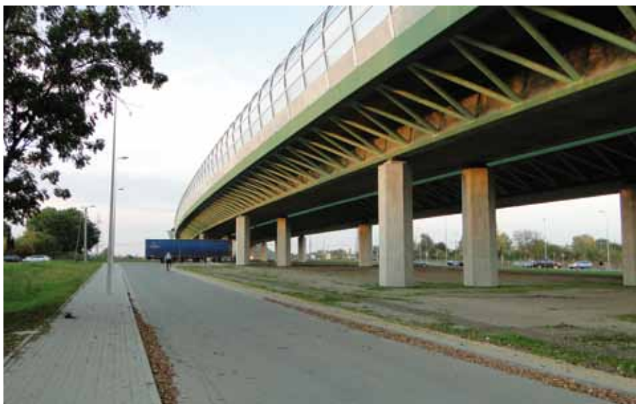
8. Estakada WA 17 nad ulicą Żernicką i linią kolejową nr 275 Wrocław-Legnica
