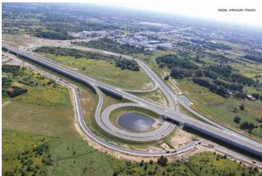
5. Węzeł „Wrocław Północ” autostrady A8 z ulicą Sułowską we Wrocławiu (DK 5), a docelowo dodatkowo z drogą ekspresową S5
