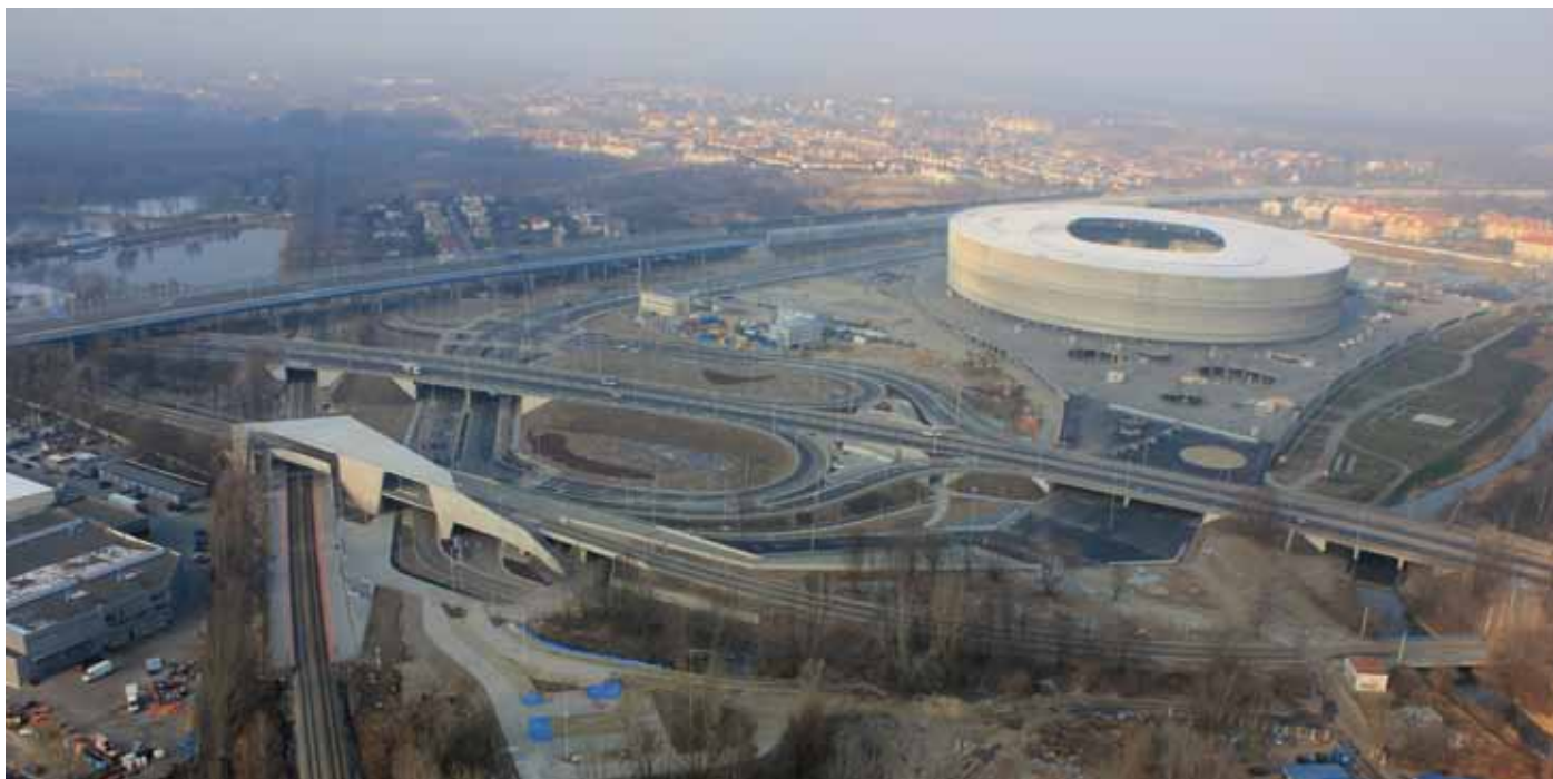
5. Ulica Lotnicza w rejonie Stadionu EURO 2012. Na pierwszym planie zintegrowany przystanek tramwajowo- kolejowy. Stan zaawansowania robót w styczniu 2012 roku (fot. W. Kluczewski)
