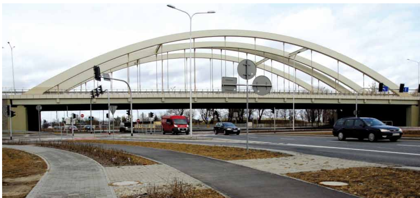
12. Wiadukt drogowy WD3 nad ul. Żmigrodzką - widok od strony południowej (fot. M. Jagiełło)
