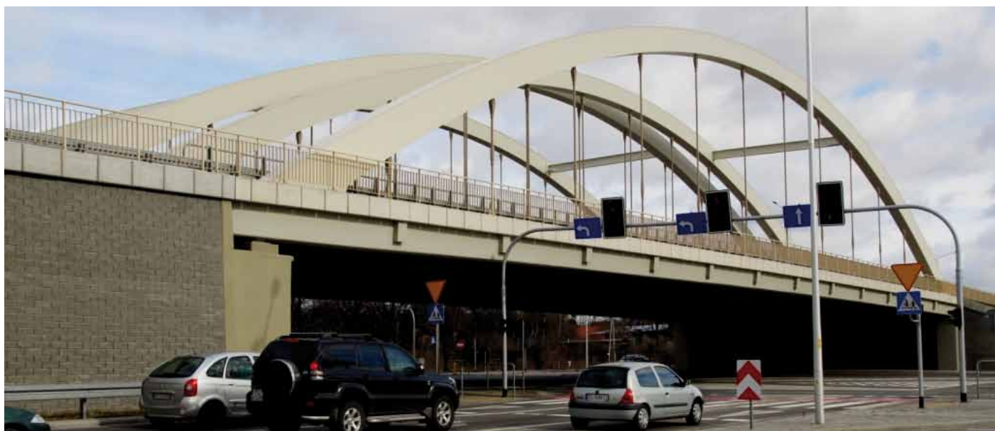
10. Wiadukt łukowy WD-3 nad ul. Żmigrodzką. (fot. M. Jagiełło)
