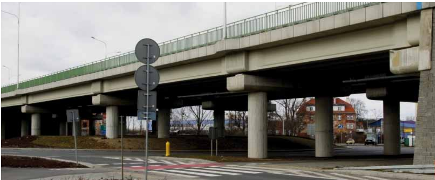
9. Wiadukt drogowy WD-2 nad rondem w ciągu ul. Obornickiej (fot. M. Jagiełło)
