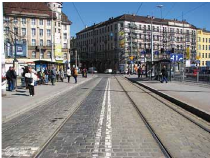
16. Przykładowe nawierzchnie z kostki kamiennej na przystankach tramwajowo-autobusowych we Wrocławiu
