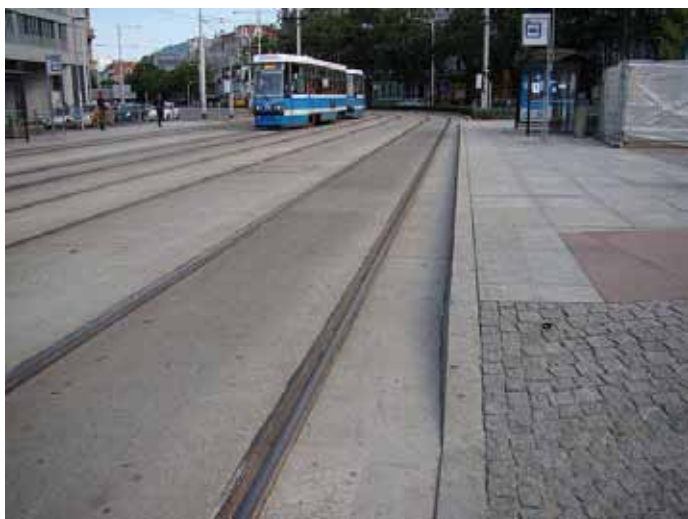
14. Nawierzchnia betonowa na przystanku tramwajowym na pasach PAT przed Rondem Regana (wlot z ul. Curie-Skłodowskiej)
