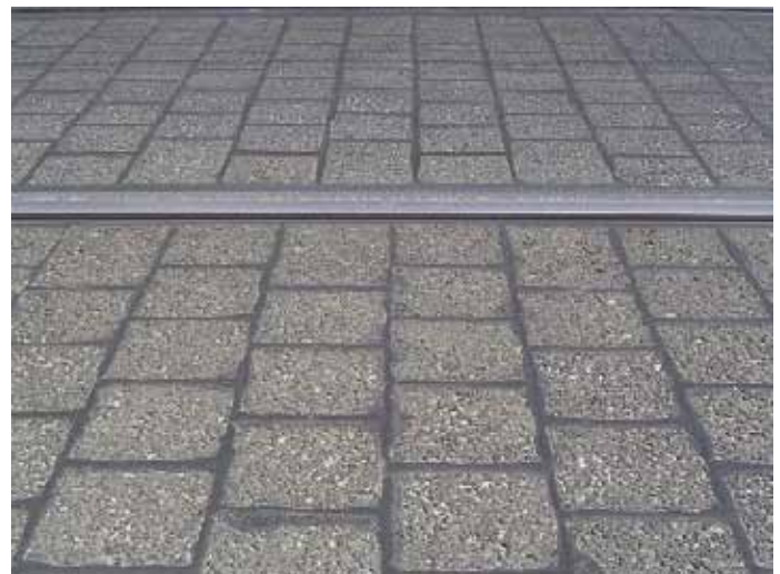
20. Nawierzchnia PAT z kostki wielkopieczowej, ułożonej w deseń prosty mijankowy z wypełnieniem spoin zaprawą asfaltową (Berlin)
