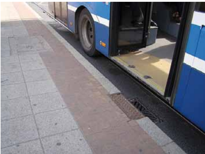
27. Niewielka szerokość zalegania zawężonego wpustu na nawierzchni PAT, zapewnia omijanie powierzchni wpustu przez koła autobusu
