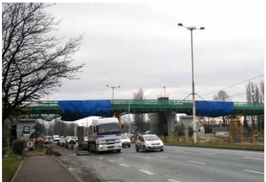
5. Budowa kładki na ul. Gdańskiej przy przystanku tramwajowym „Merkatora”
