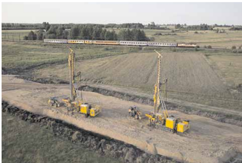
3. Wykonywanie kolumn żwirowo-betonowych KSS/FSS wibratorem wglębnym metodą wibrowymiany na odcinku „prostowania torów” (km 125)
