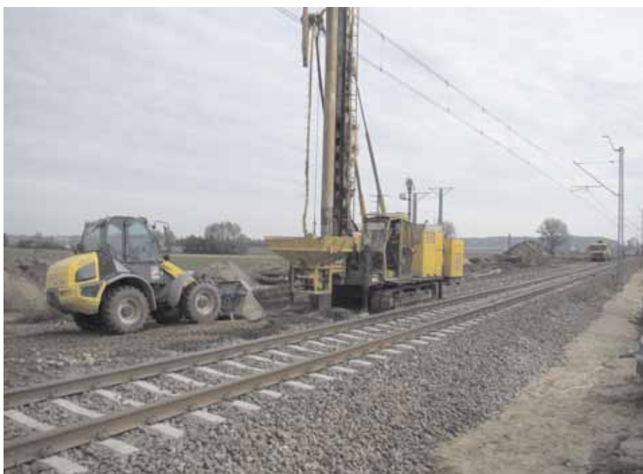
6. Prace przy wykonywaniu kolumn żwirowo-betonowych w bezpośredniej bliskości czynnego toru w rejonie km 106
