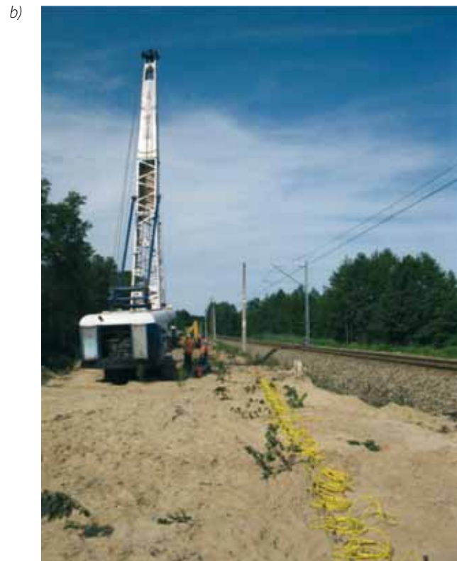
2. Urządzenia dźwigowe wraz z ubijakiem do formowania kolumn: a) na poletku nr 1, b) na poletku nr 2
