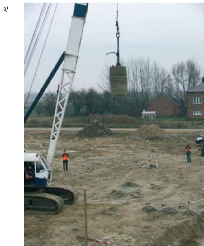
2. Urządzenia dźwigowe wraz z ubijakiem do formowania kolumn: a) na poletku nr 1, b) na poletku nr 2
