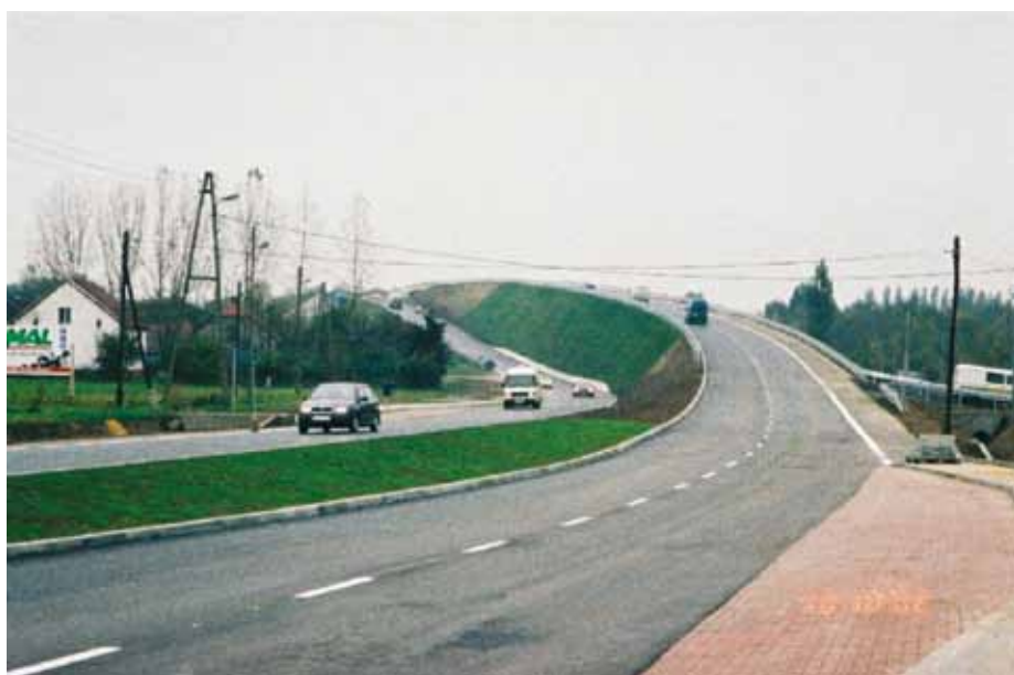
1. Widok wykonanego nasypu w ciągu DW 933 od strony miasta Jastrzębie Zdrój w kierunku Pawłowic w dniu oddania obiektu do eksploatacji w 2002 r.
