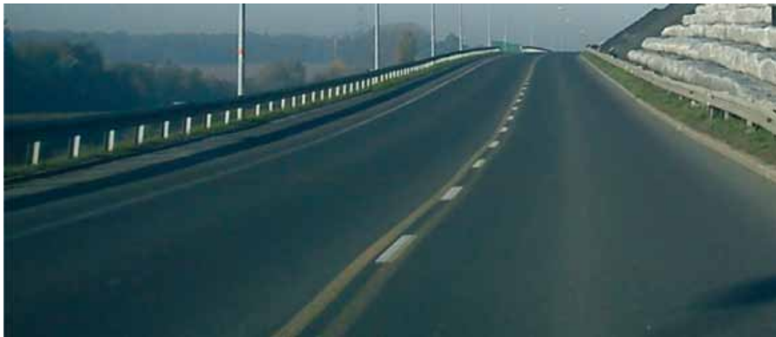
24. Widok na nawierzchnię „nowego” nasypu, wybudowanego w 2002 roku w trakcie remontu nitki po stronie północnej – stan na rok 2012
