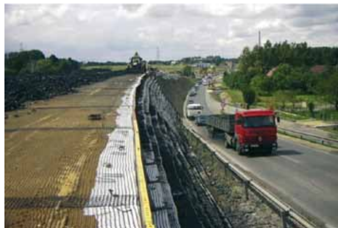
19. Widok warstw zbrojenia geosyntetycznego – konstrukcja w szalunkach przestawnych
