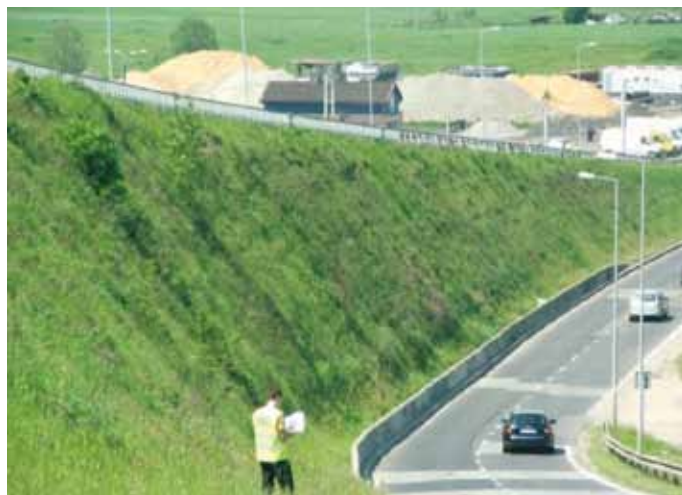
21. Widok na skarpę „nowego” nasypu i nawierzchnię „starego” nasypu – stan na rok 2011
