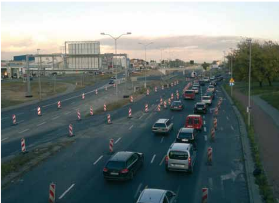
4. Utrudnienia komunikacyjne związane z przebudową ul. Struga
