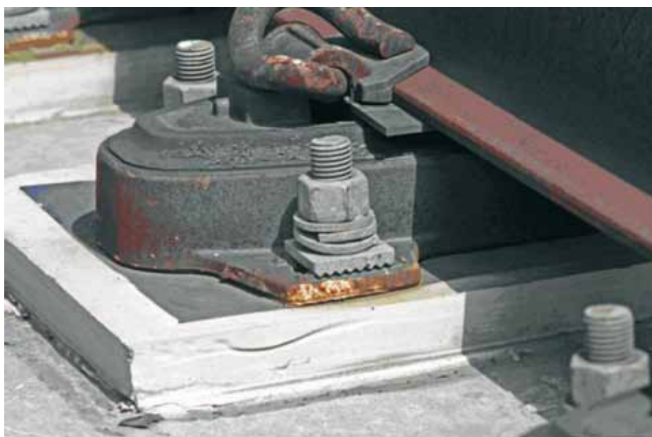
2. Nowe rozwiązania bloku przytwierdzeń izolujących szyny kolejowe
