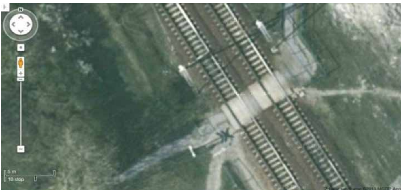
10. Zbliżenie przejścia z rys. 7
