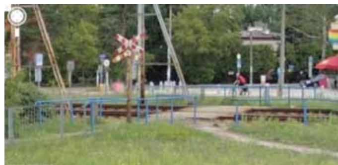
12. Wschodnia strona linii, widoczna sygnalizacja uliczna na skrzyżowaniu
