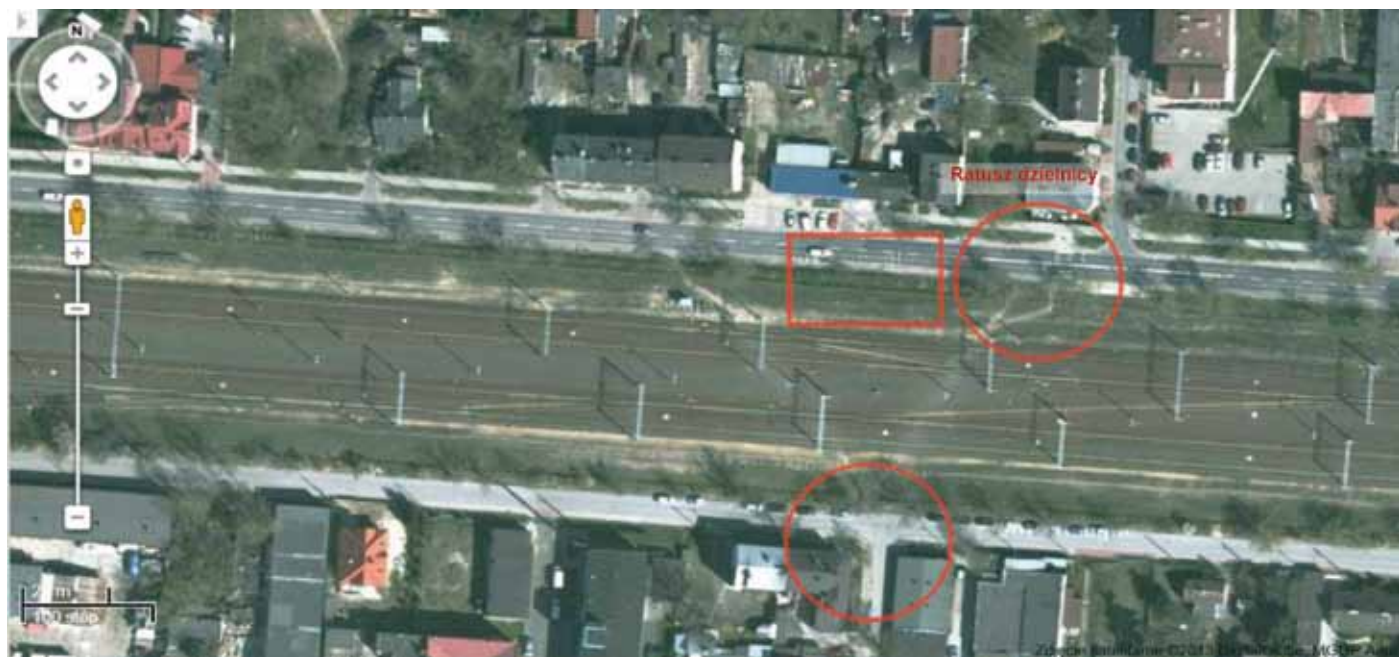
2. Zbliżenie na środek odcinka między dwoma przejściami podziemnymi przez tory
