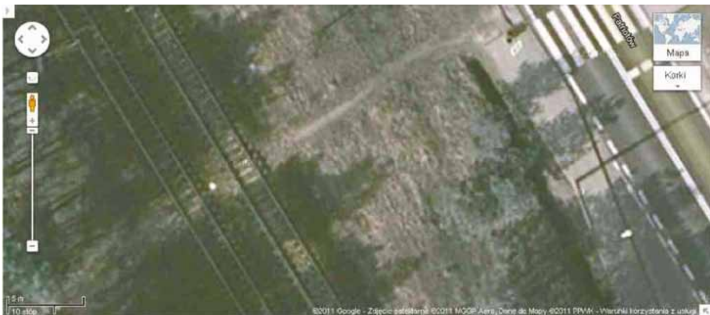
13. Widoczność uszkodzenia nawierzchni spowodowane dzikim przejściem przez tory
