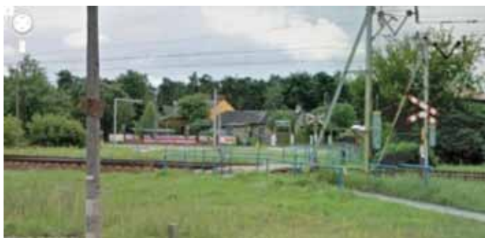
11. Widok na przejście kat. E
